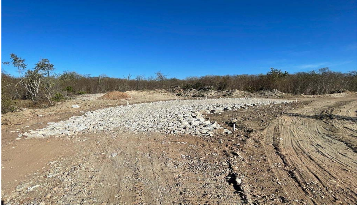
FOTO 143 – Execução de enrocamento nas estradas de acesso.
