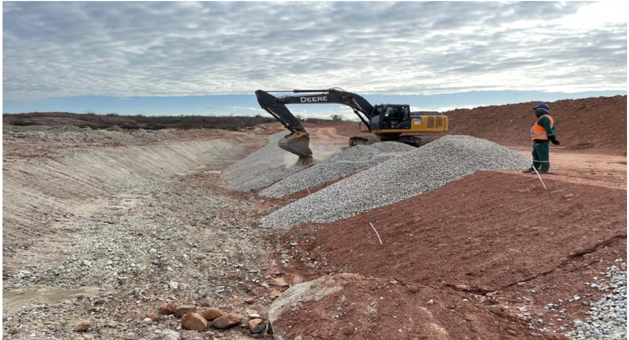
FOTO 33 – Execução de camada de transição do rip-rap
