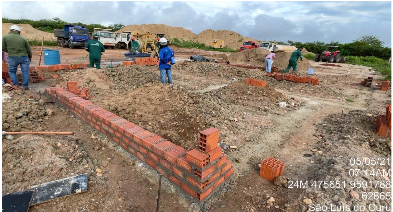
FOTO 87 – Fundação da casa do AGIR – (embasamento com pedra argamassada e execução do baldrame.)
