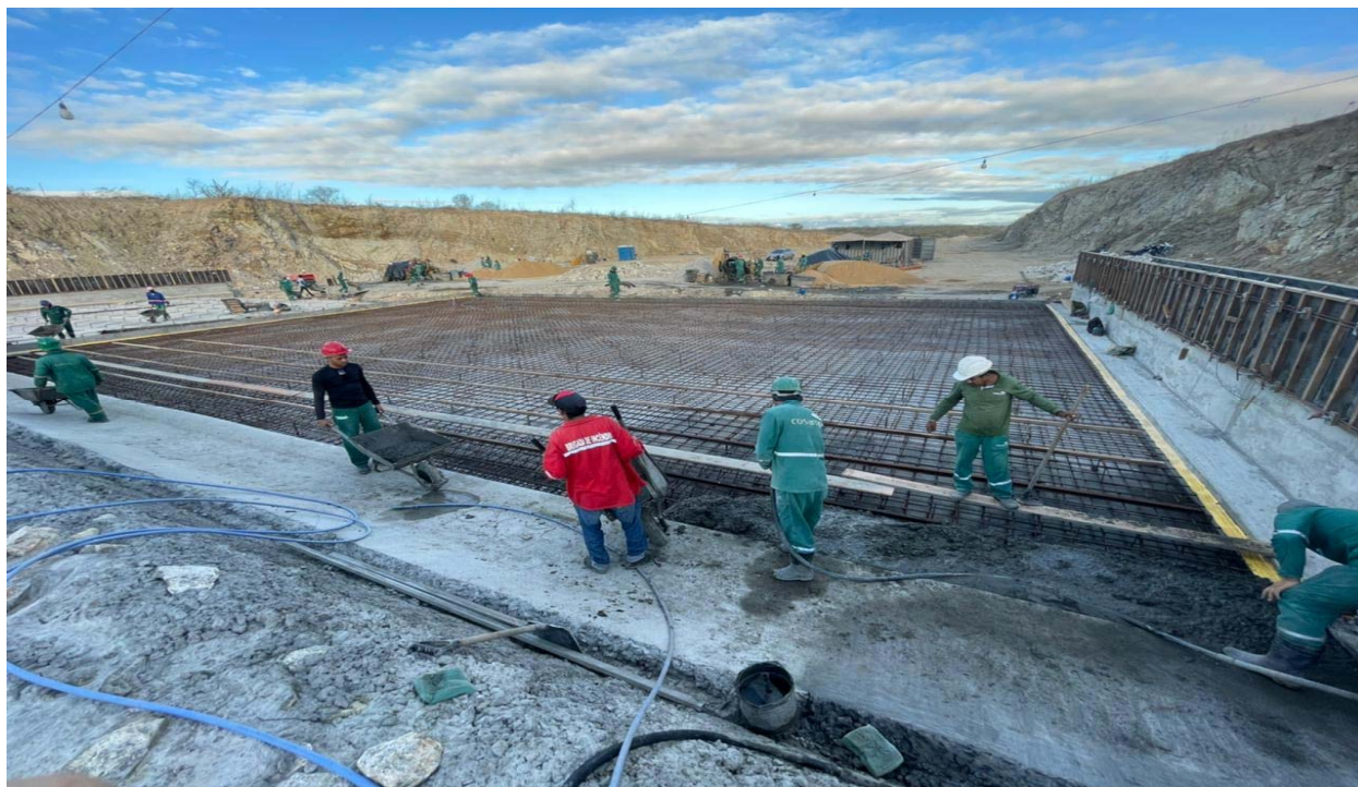
FOTO 129 – Concretagem da primeira etapa da laje da bacia de dissipação
