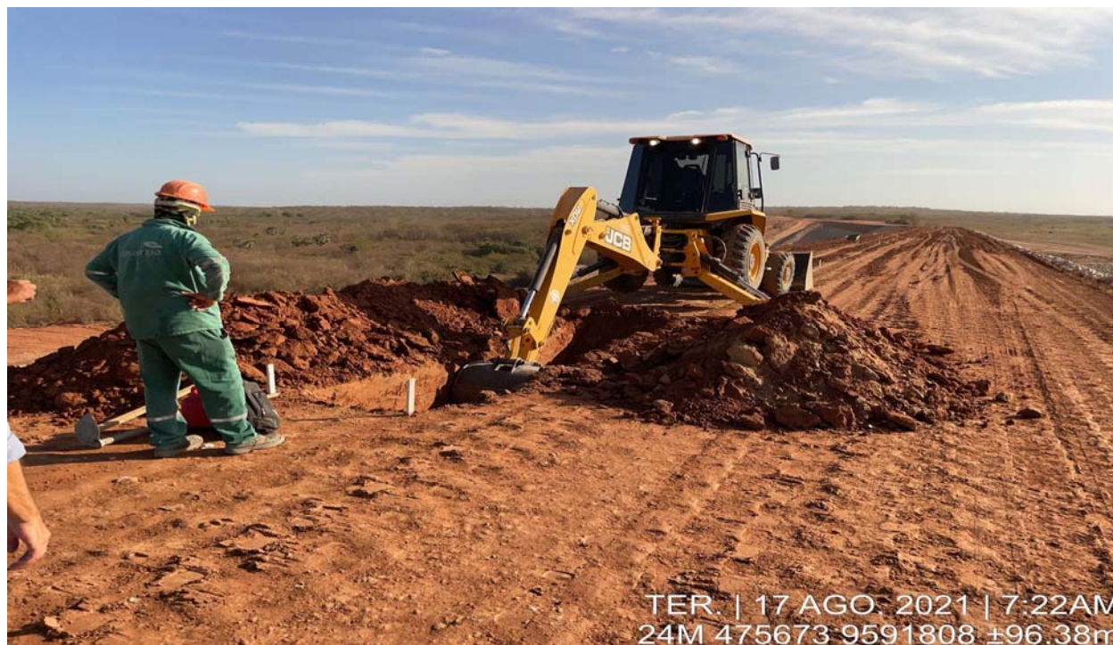
FOTO 137 - Execução do filtro vertical (barragem Melancia)
