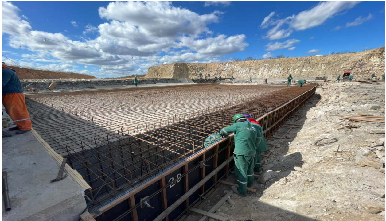
FOTO 125 – Execução de forma para concretagem do redente (laje da bacia de dissipação)
