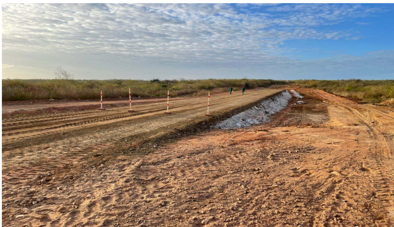
FOTO 122 - Coroamento e compactação da barragem auxiliar 01
