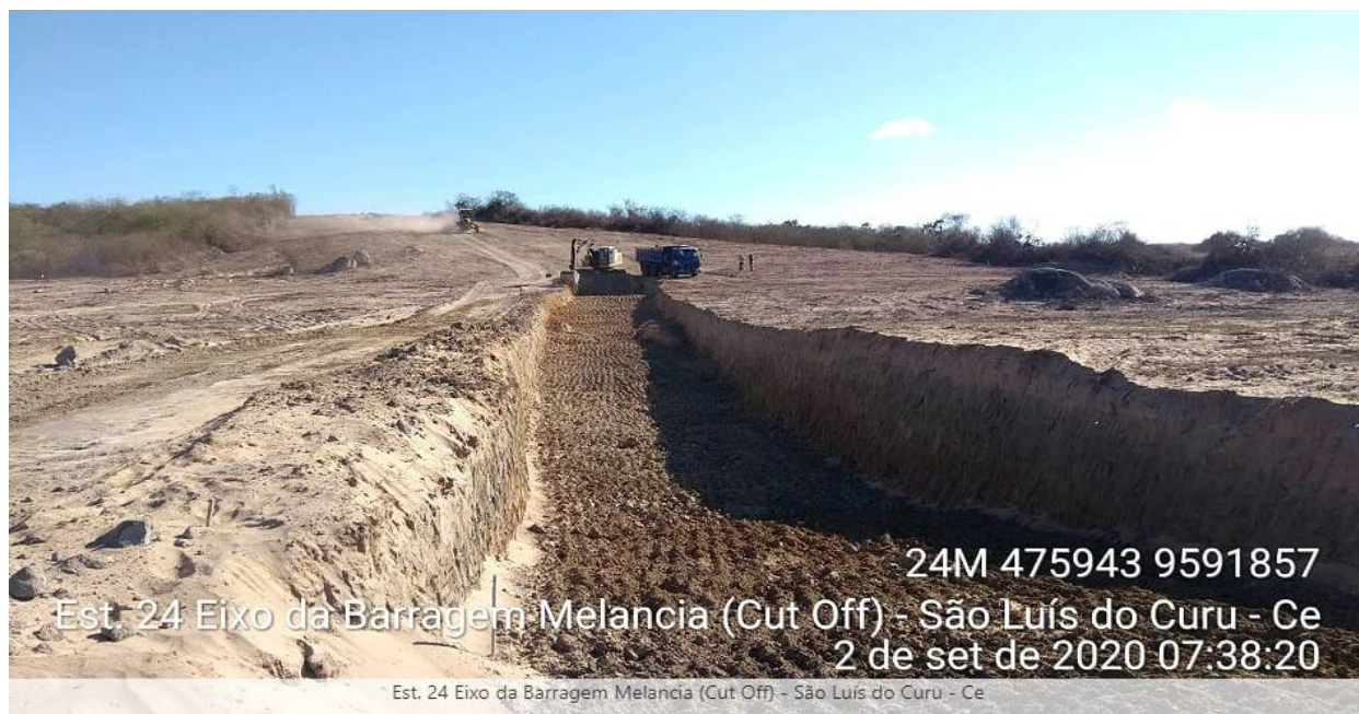
FOTO 03 – Escavação no barramento principal (cut-off. Est.24)
