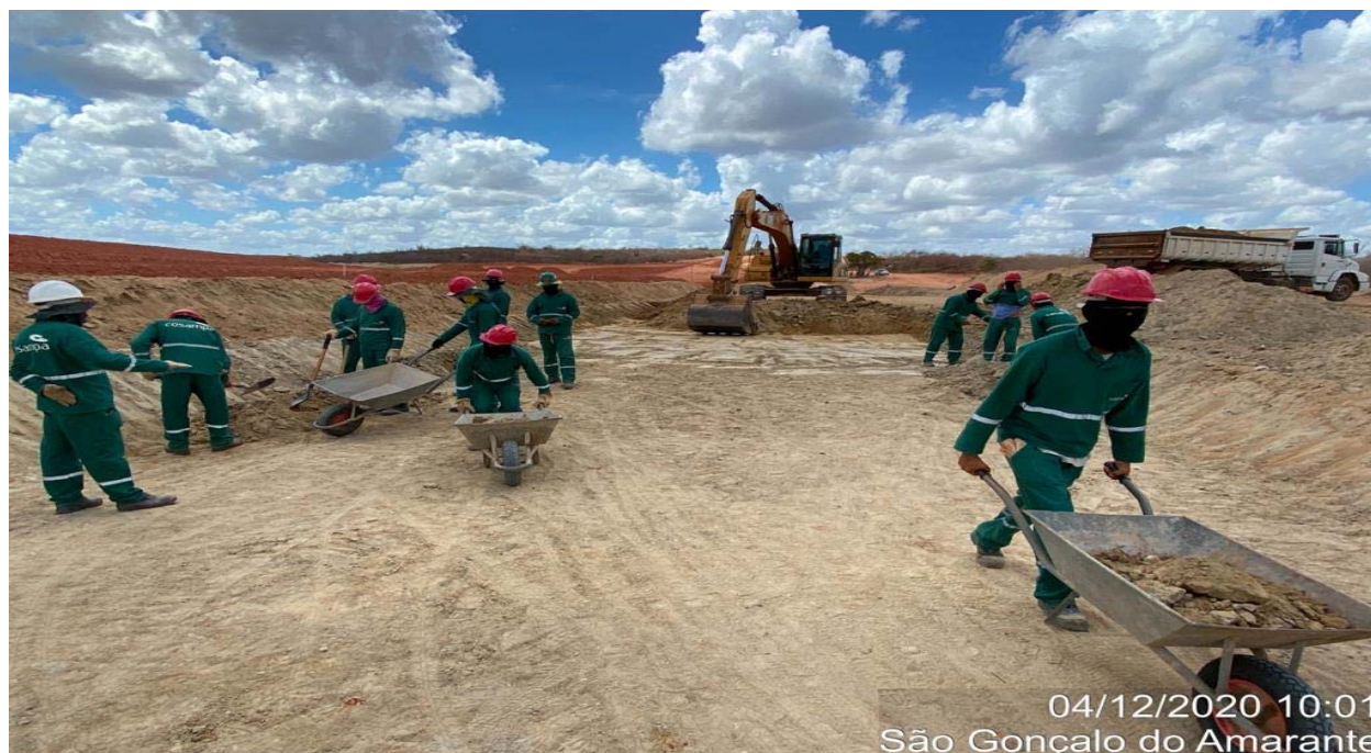
FOTO 25- Escavação e limpeza no rock fill
