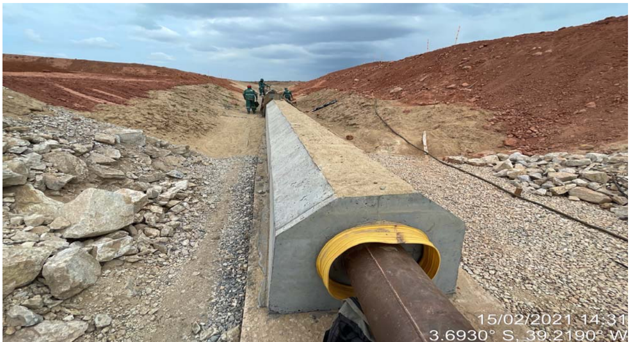
FOTO 56- Concretagem do módulo 02 na tomada d'água
