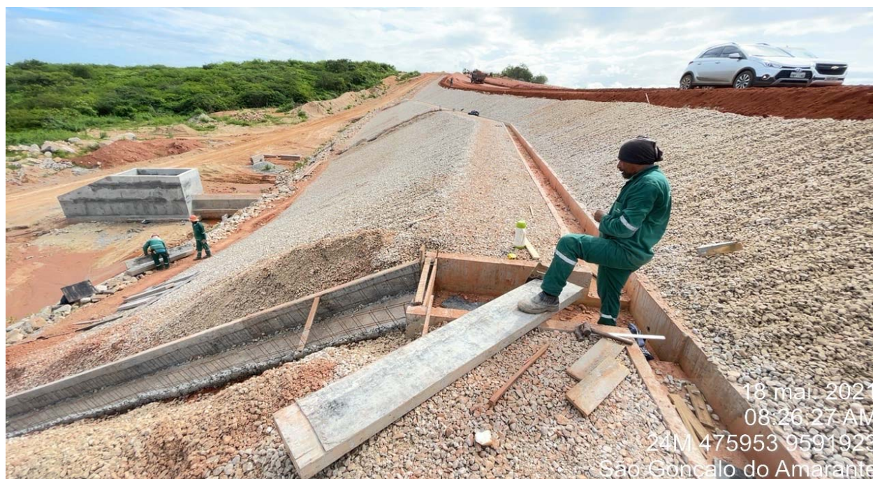
FOTO 94 - Execução de formas para canaletas de decida – talude de jusante
