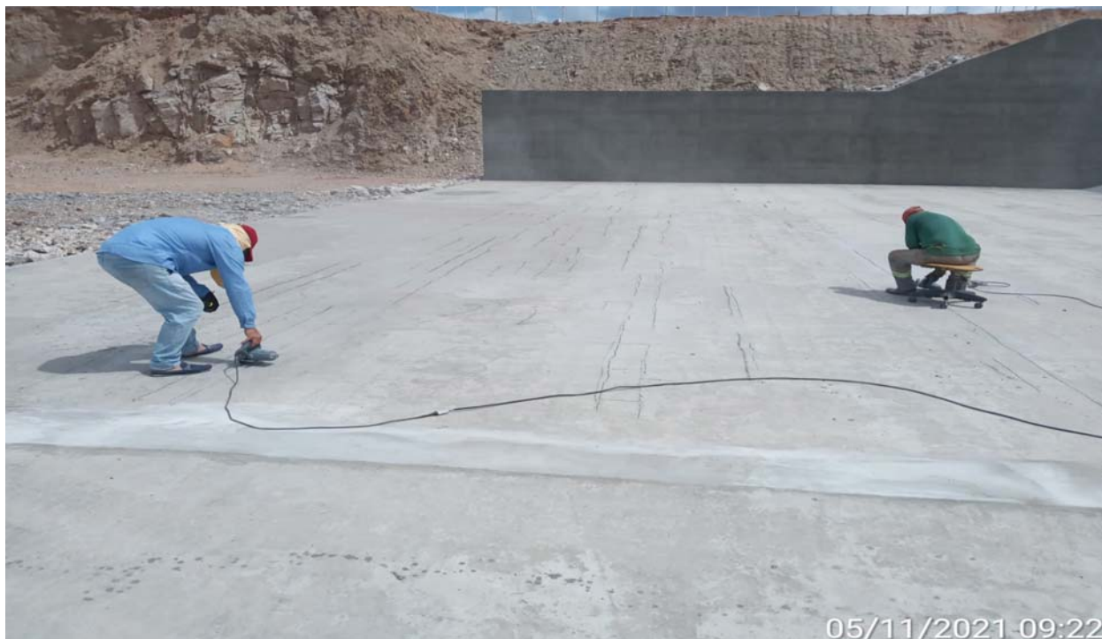
FOTO 167 - Execução de tratamento nas micro fissuras da laje da bacia de dissipação
