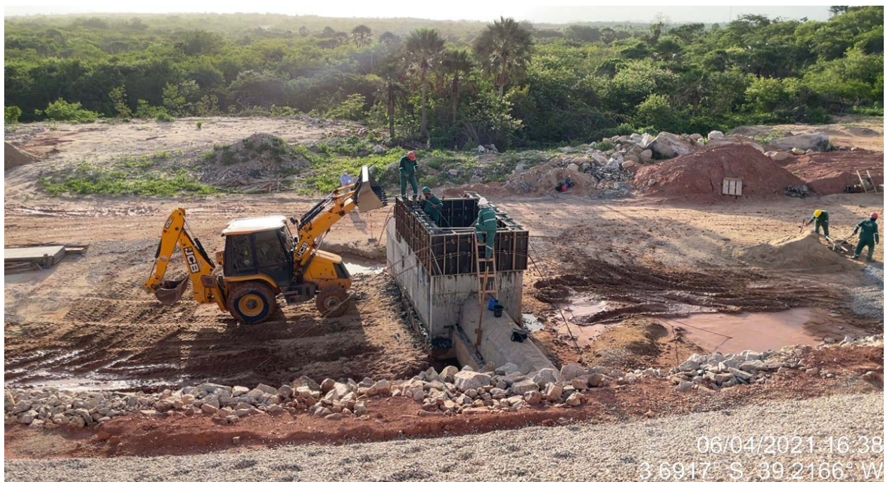
FOTO 76 - Concretagem da caixa de jusante – tomada d'água
