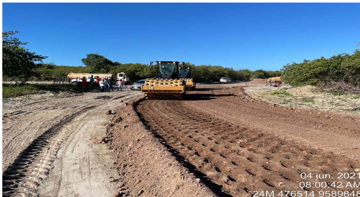
FOTO 97 - Execução das estradas de acesso sul (compactação)
