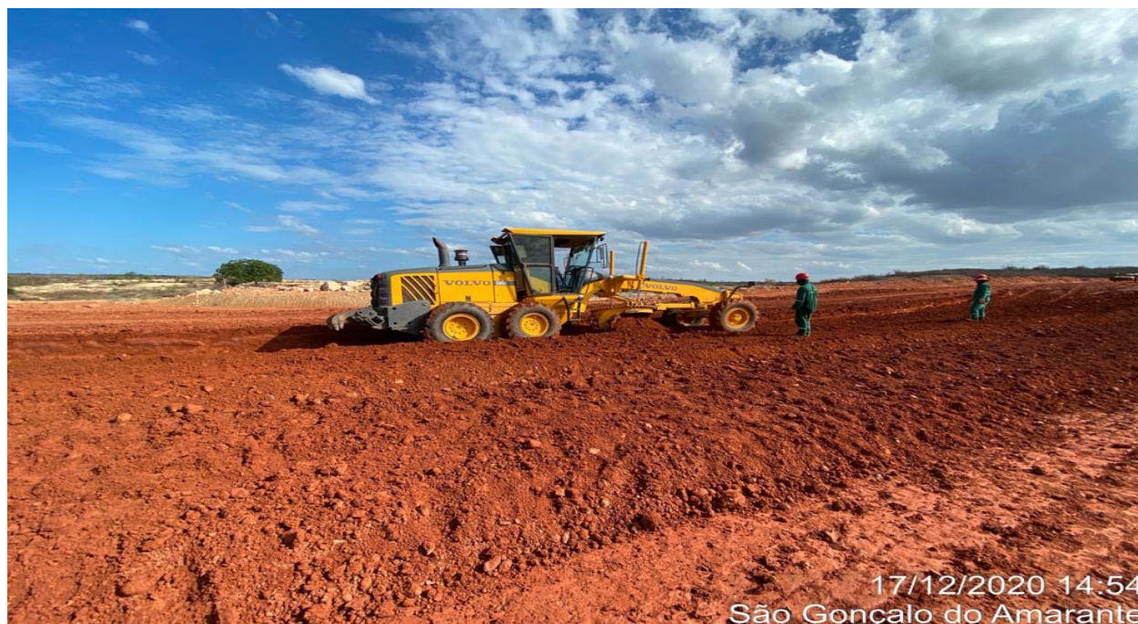
FOTO 31 - Tratamento do material – maciço da Barragem
