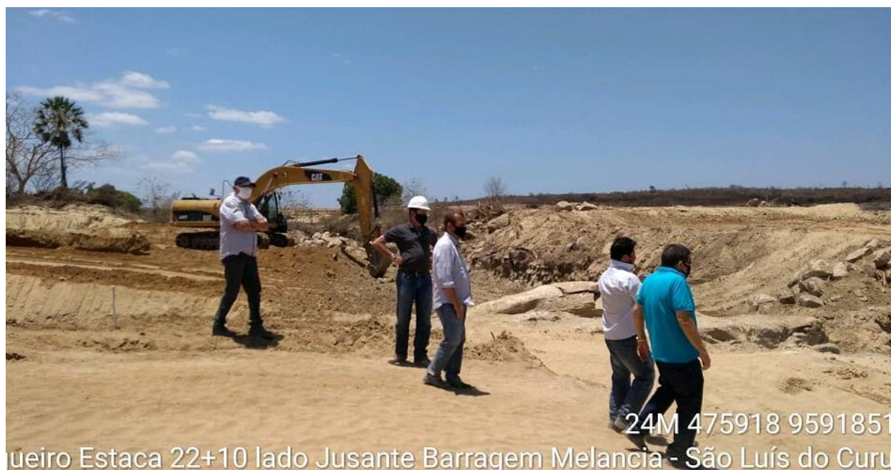
FOTO 06 – Visita do diretor da SOHIDRA, Dr. Lucena às obras da barragem em 19/09/2020.
