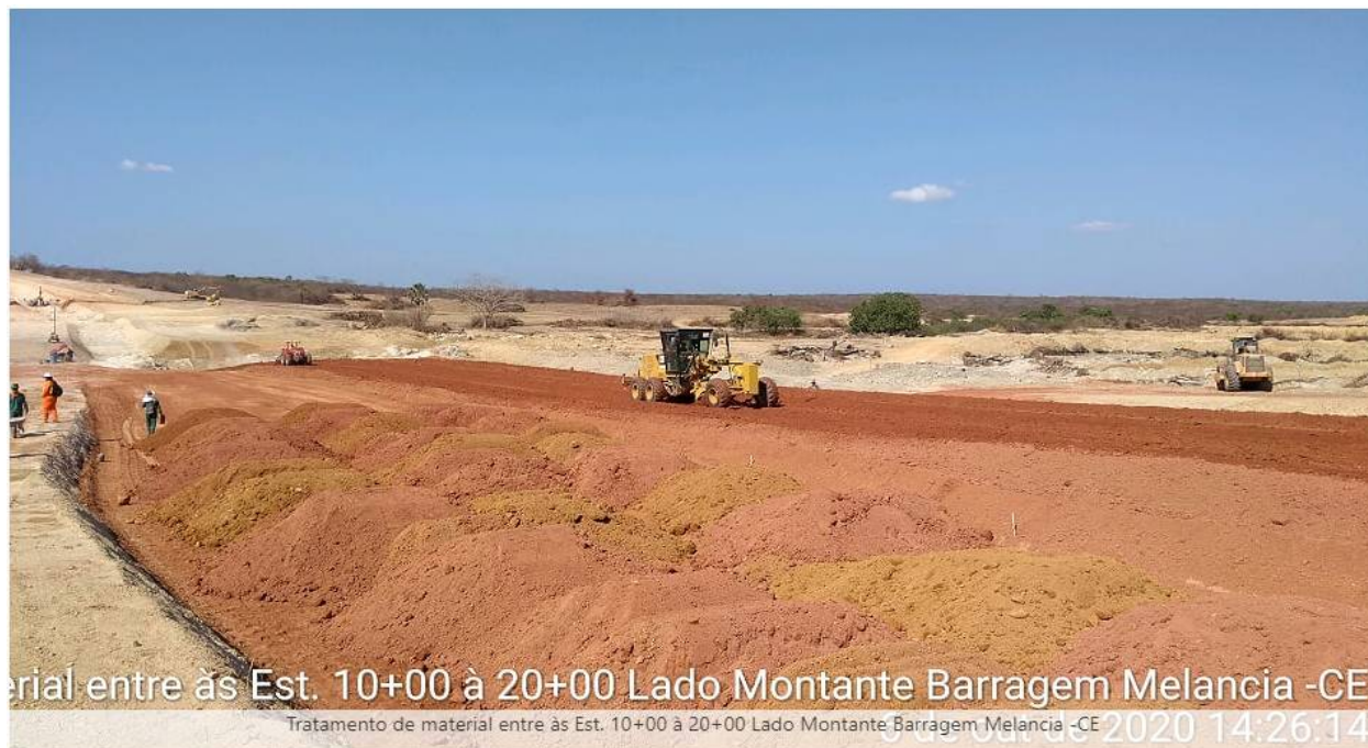
FOTO 09 - Tratamento de material no barramento principal. (Est.10)
