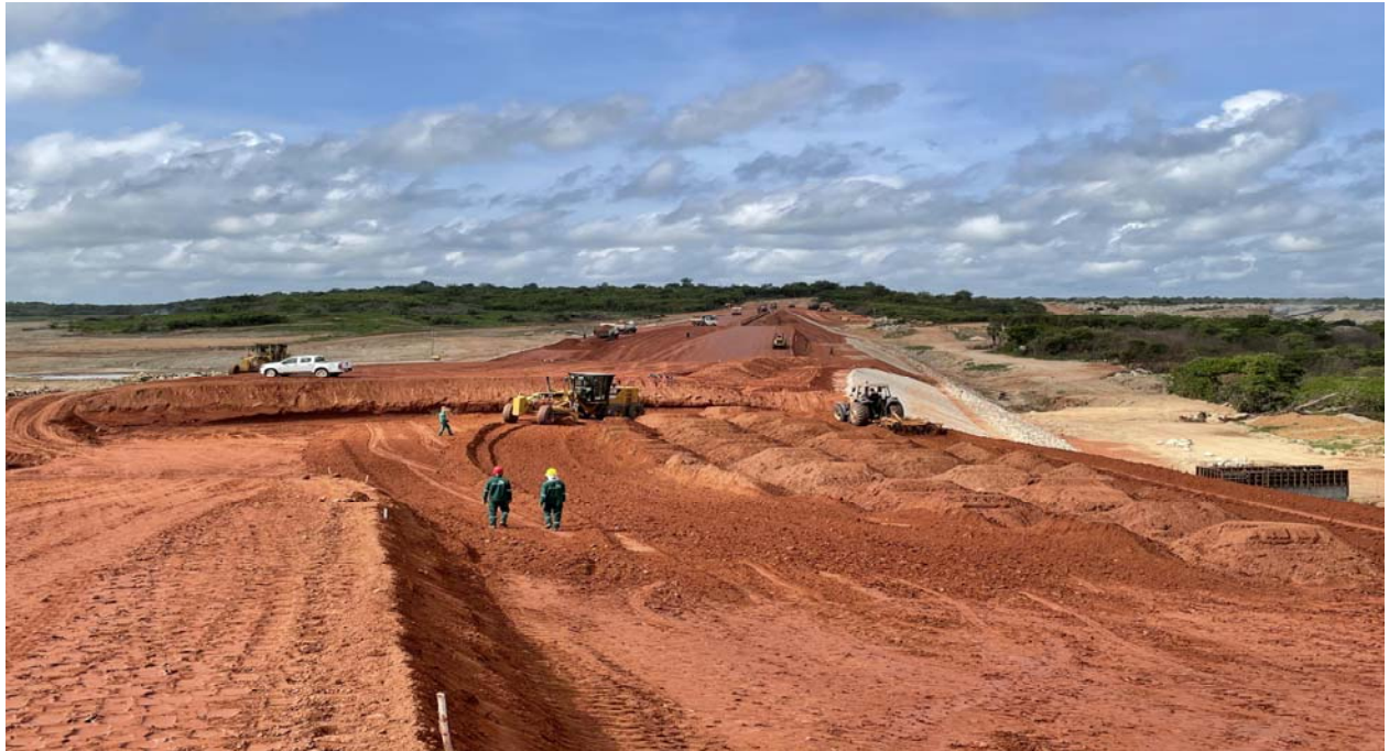
FOTO 71 - Tratamento do material – barramento Principal
