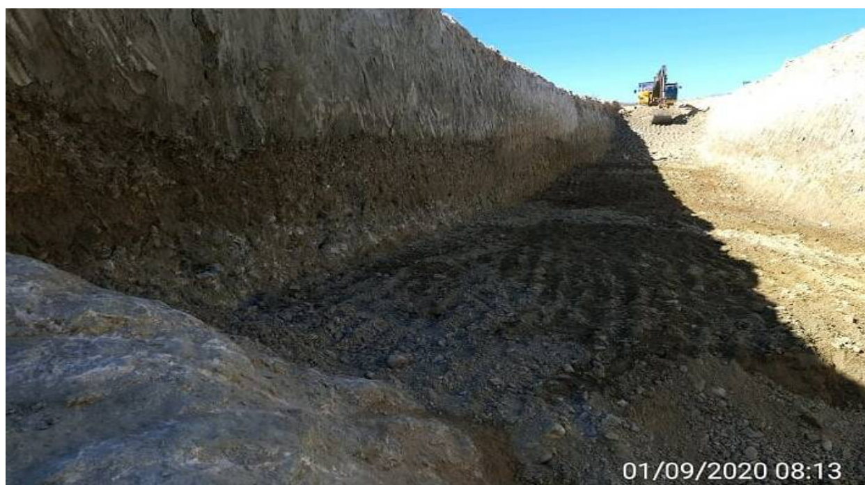
FOTO 04 – Detalhe da lente de cascalho presente na formação do solo no barramento principal.
