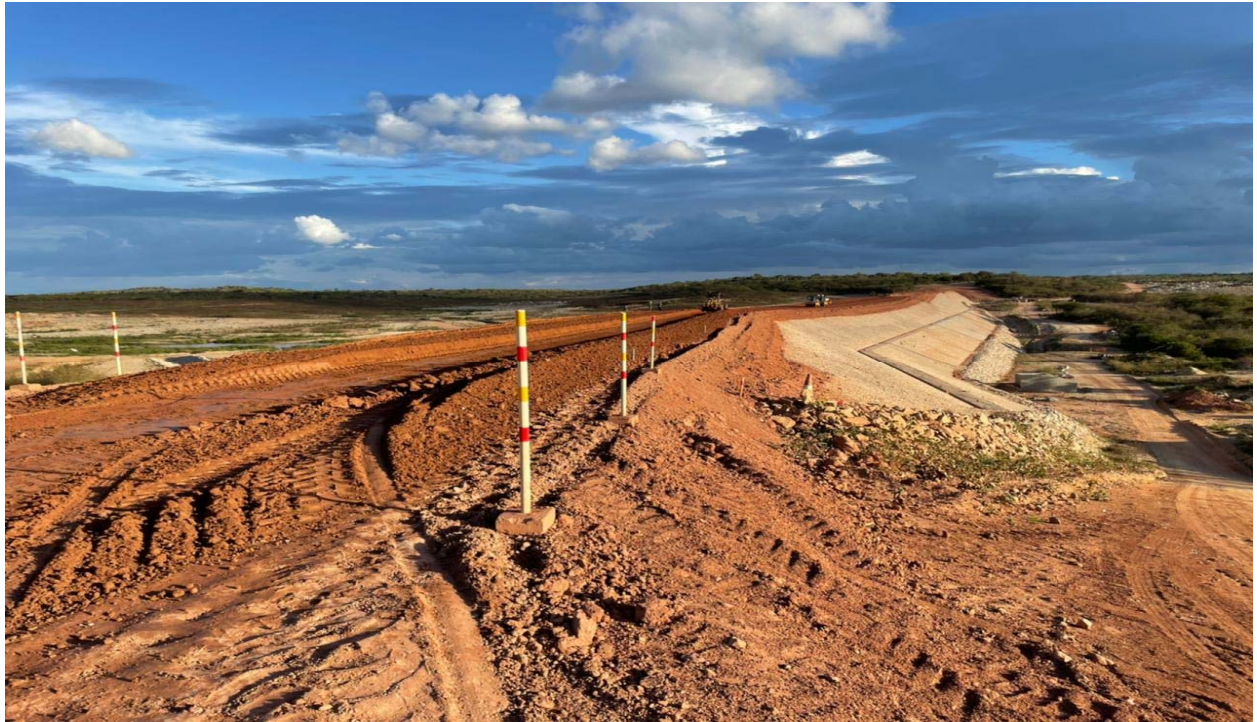
FOTO 113 - Vista panorâmica da barragem Melancia (ombreira direita)
