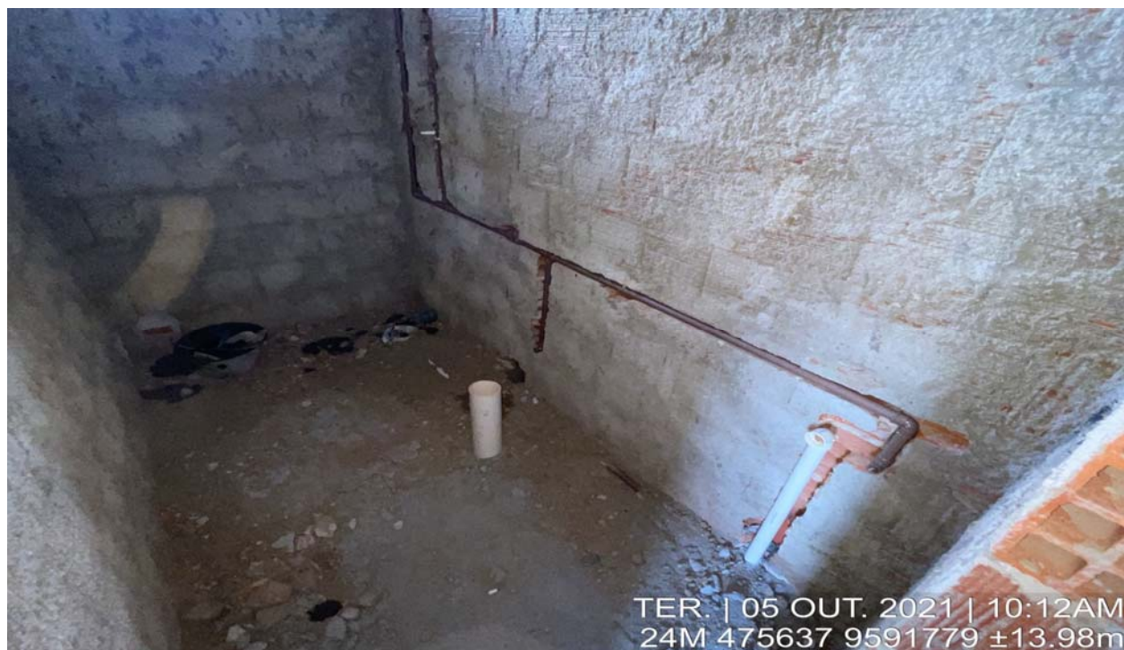
FOTO 149- Execução das instalações hidráulicas da casa do AGIR
