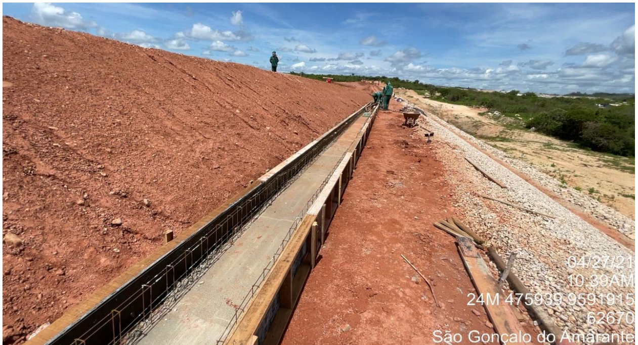
FOTO 80 - Execução das formas das canaletas (Berma)
