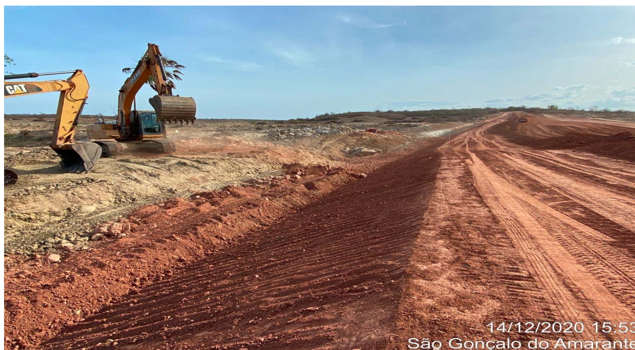
FOTO 28 – Execução de rampa para o rip- rap (Montante do Barramento Principal)
