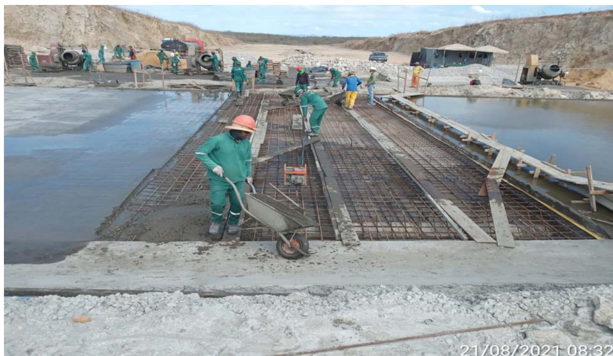
FOTO 140 - Concretagem da segunda etapa da laje da bacia de dissipação
