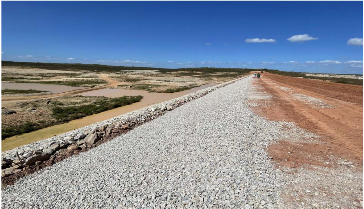
FOTO 119 - Execução da camada de transição do rip-rap
