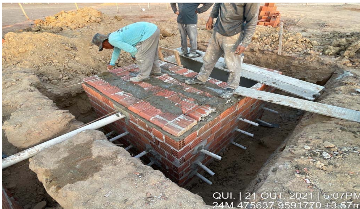
FOTO 157- Execução de fossa séptica da casa do AGIR
