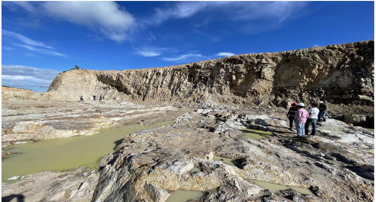
FOTO 90 - Inspeção de campo - vertedouro
