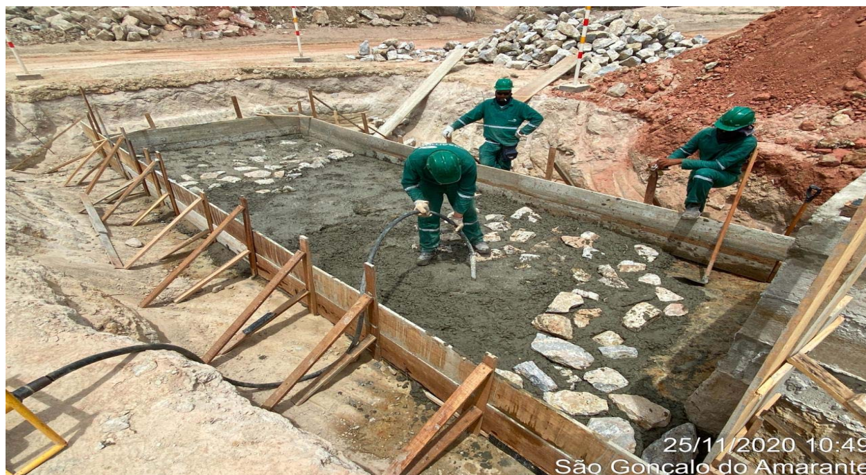
FOTO 23 – Adensamento de concreto ciclópico na caixa jusante (Est. 11+15)
