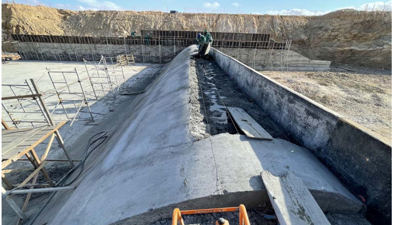
FOTO 145 - Execução do concreto convencional do muro Creager (ogiva)
