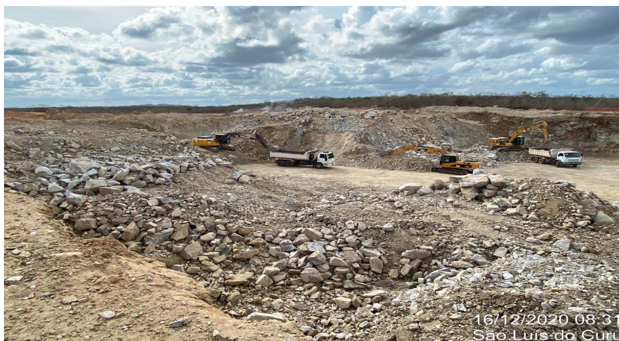
FOTO 32 - Retirada de material de detonação nas escavações do vertedouro.
