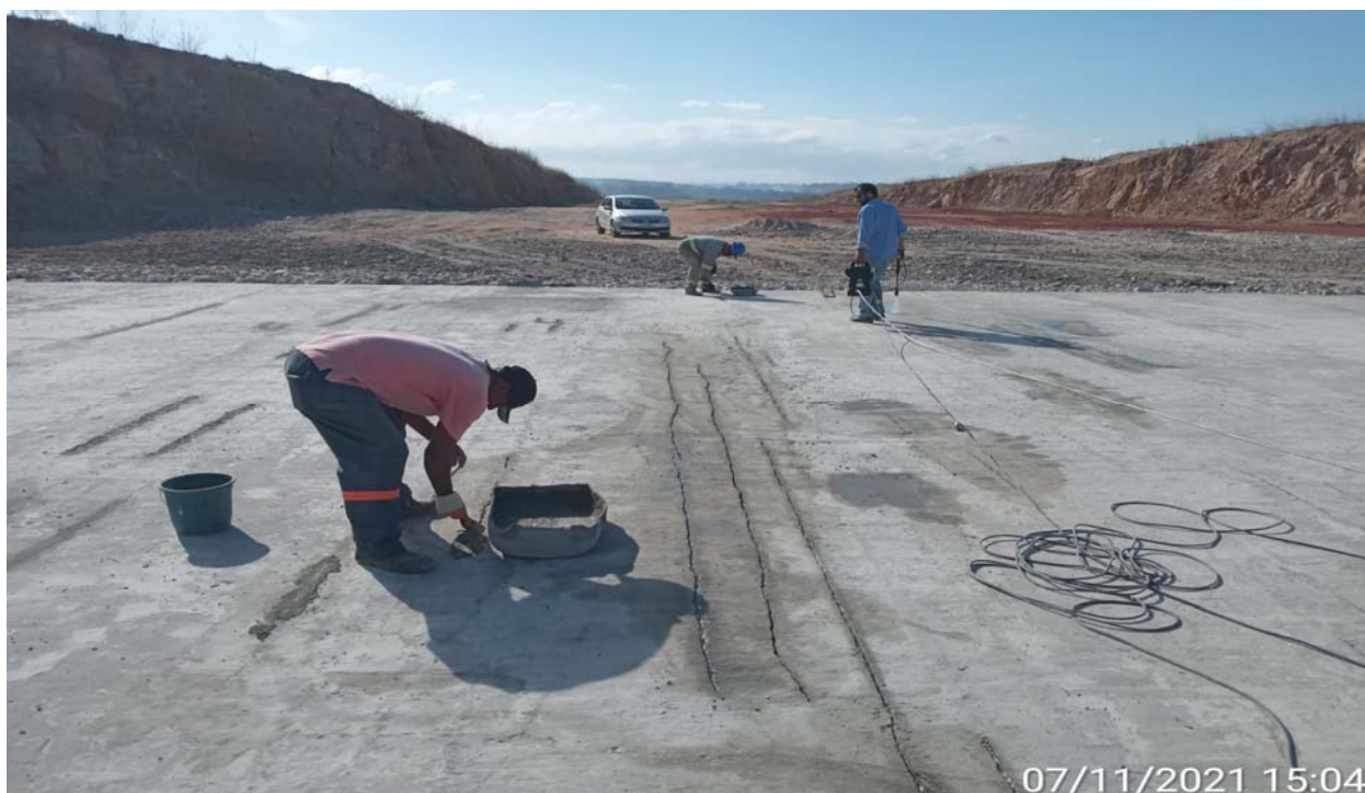
FOTO 168 - Execução de tratamento nas micro fissuras da laje da bacia de dissipação
