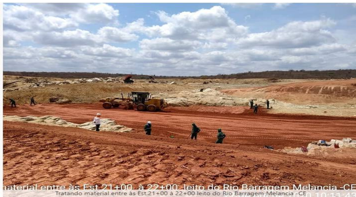
FOTO 12 - Lançamento de material no barramento principal. (Est.21 a 22)
