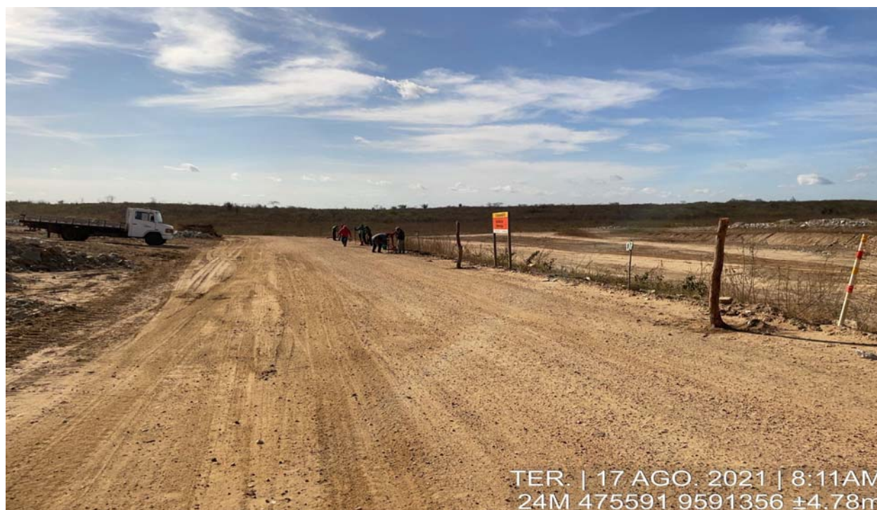
FOTO 138 - Execução de cerca de proteção do vertedouro
