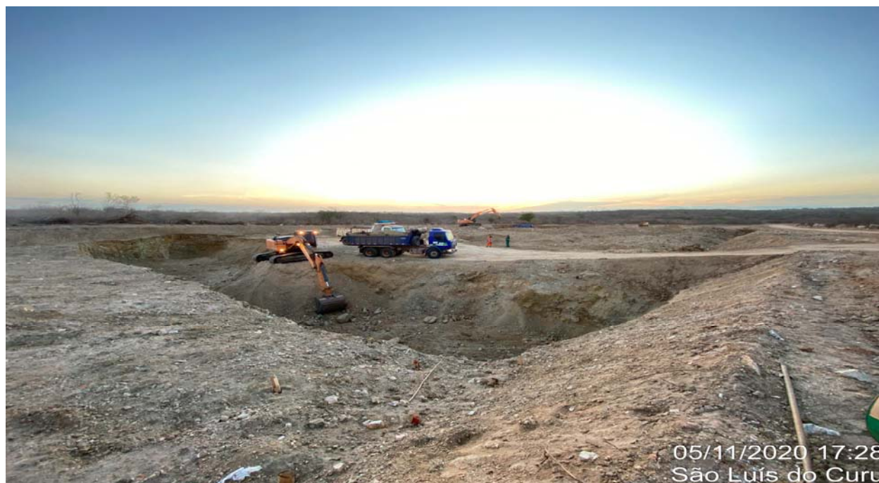
FOTO 17 – Escavação e transporte de rocha – material de 3º categoria (Est. 27 a 31)
