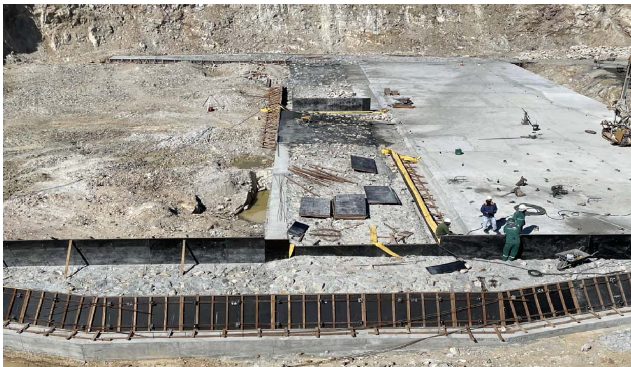
FOTO 117 - Execução do concreto ciclópico no muro Creager
