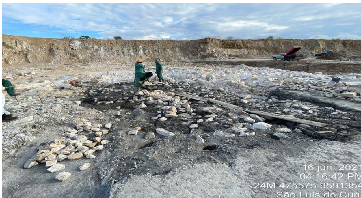
FOTO 107 - Execução de concreto de regularização na da laje de dissipação – vertedouro
