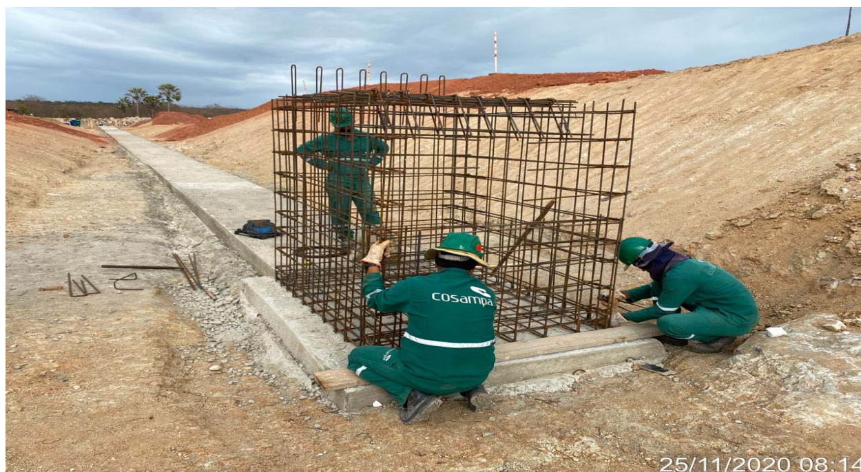
FOTO 24 – Armação da ferragem na caixa de montante da tomada d'água
