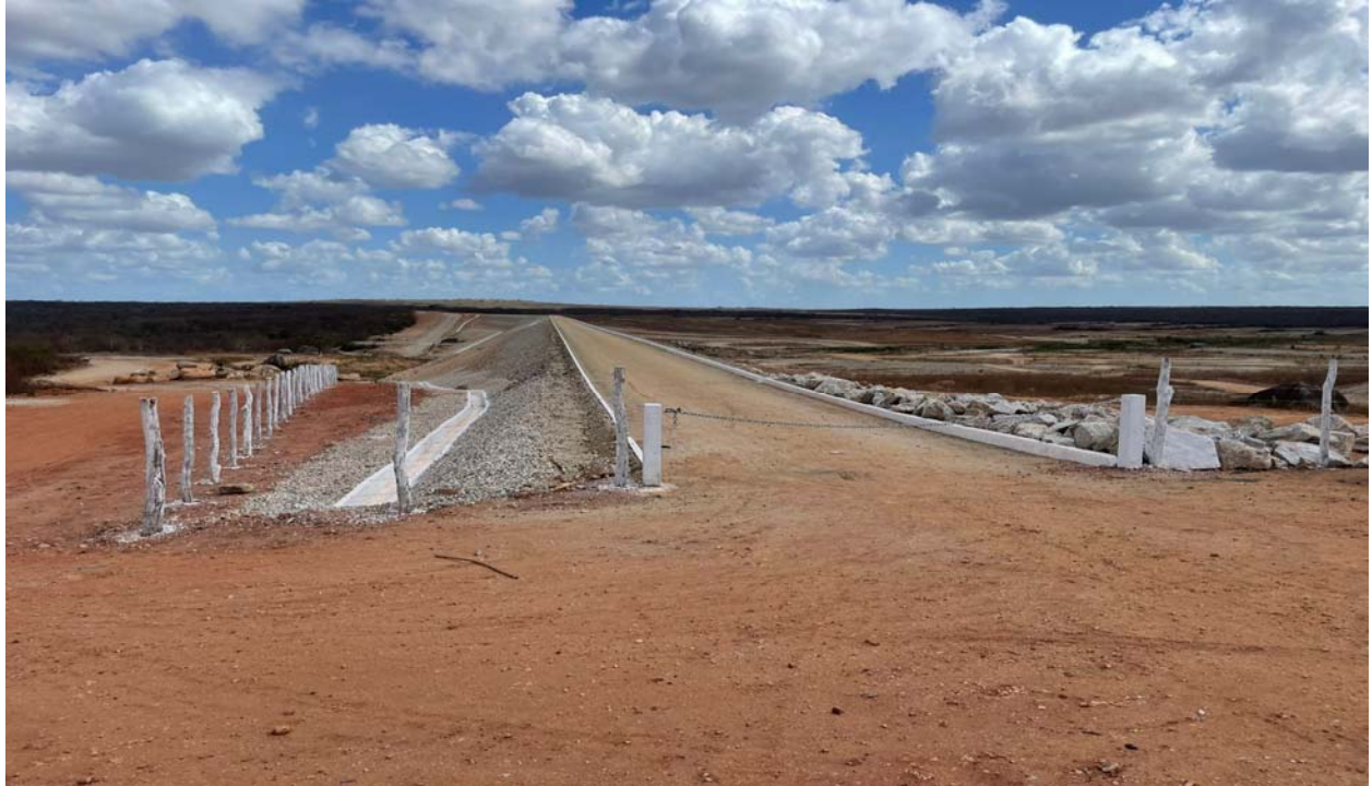
FOTO 177 - Vista da barragem Melancia. (ombreira direita)
