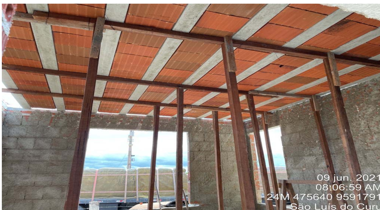
FOTO 100 - Escoramento da laje – casa do AGIR
