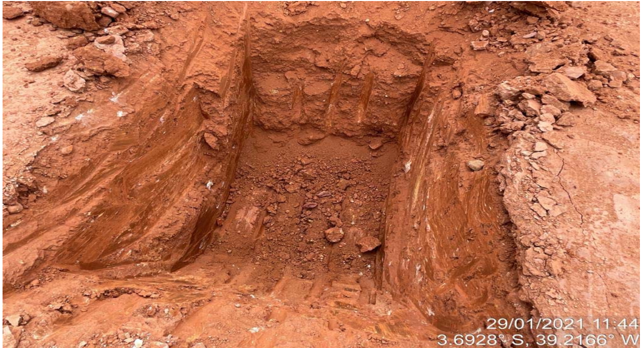
FOTO 49- Abertura de janela para inspeção da compactação do aterro (Vala 03)
