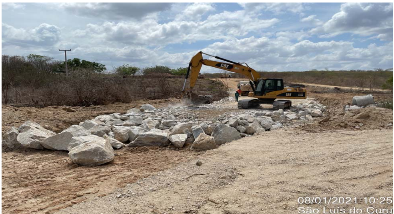
FOTO 33 – Execução de camada de transição do rip-rap
