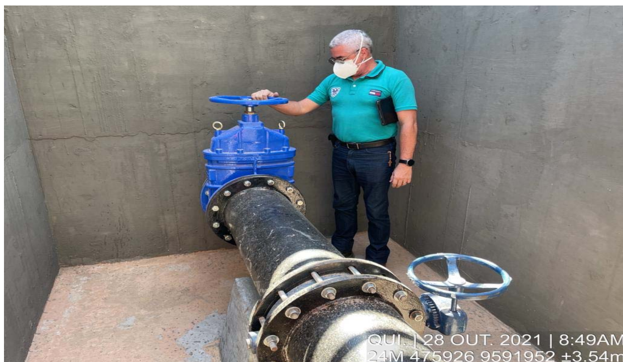
FOTO 162- Inspeção nos equipamentos hidromecânicos da tomada d'água (caixa de jusante)
