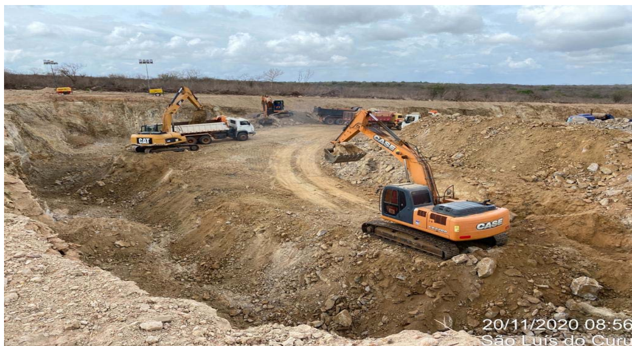
FOTO 22 – Escavação e transporte de rocha- material de terceira categoria – vertedouro (Est 24 a 28)
