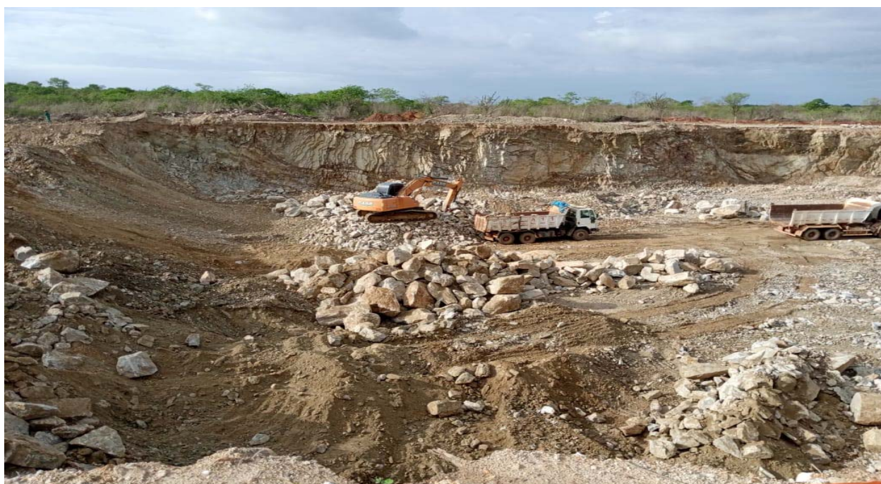
FOTO 44- Escavação e transporte de rocha no vertedouro (Est 19 a 20)
