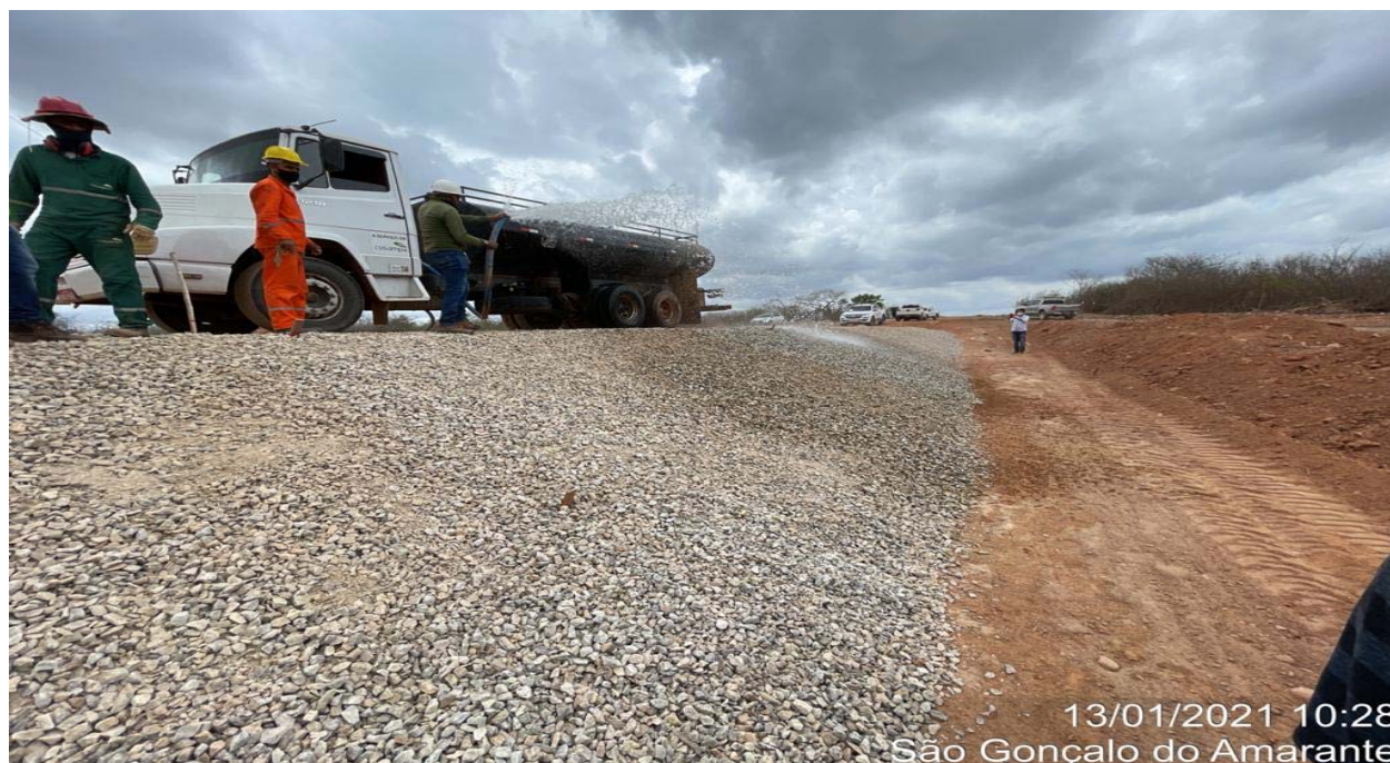
FOTO 39 – Teste de infiltração na proteção de jusante da barragem auxiliar 02
