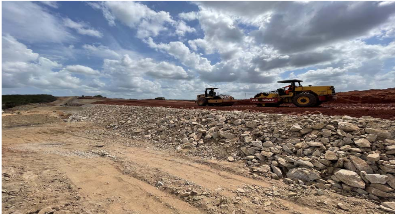
FOTO 55- Compactação de camadas próximo ao rock fill
