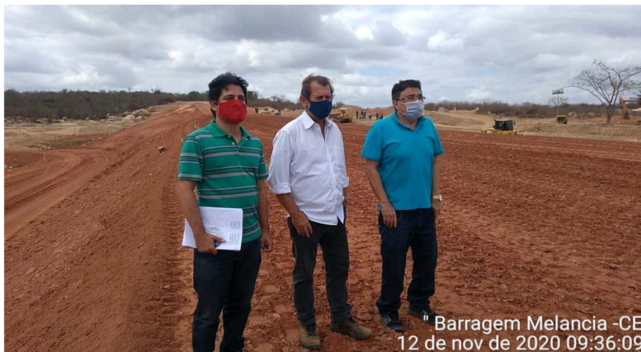
FOTO 19 - Visita do diretor da SOHIDRA, Dr. Lucena às obras da barragem Melancia
