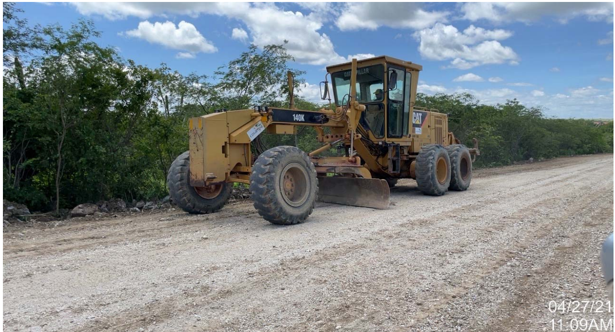
FOTO 81 - Execução da estrada de acesso ao vertedouro
