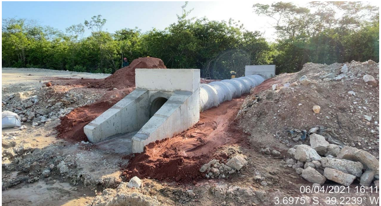
FOTO 75 - Estrada de acesso ao vertedouro- bueiro 04
