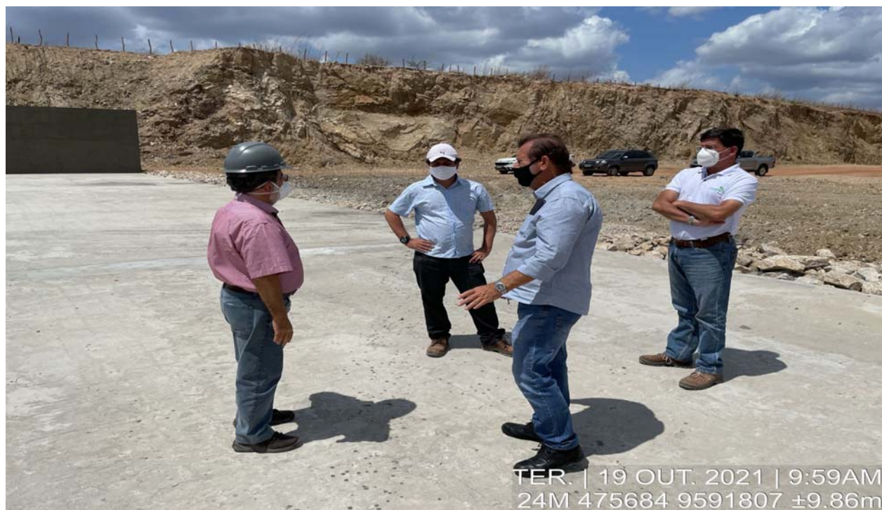
FOTO 155- Visita técnica do consultor José Ramalho - análise das micro fissuras na laje da bacia de dissipação vertedouro
