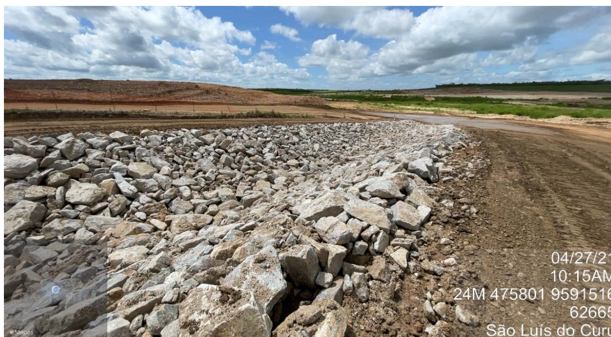
FOTO 78 – Execução das proteções em rocha, canal de entrada da caixa de montante – tomada d'água.
