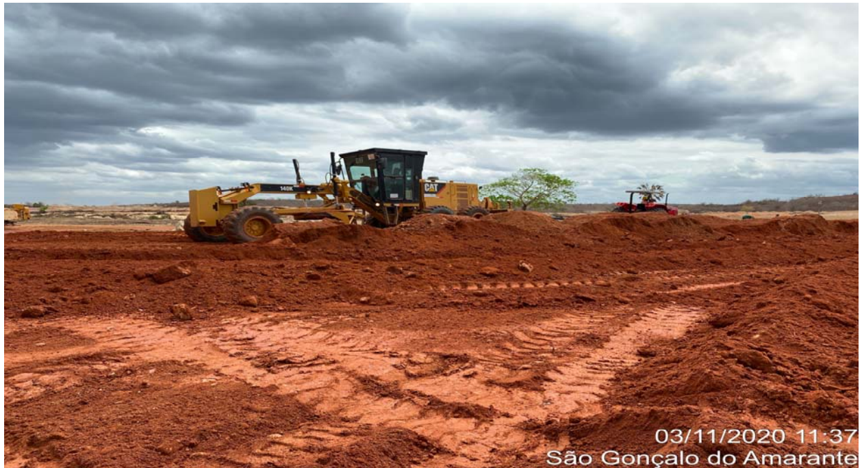
FOTO 15 – Tratamento da camada de solo no cut-off (Est. 13 a 10)
