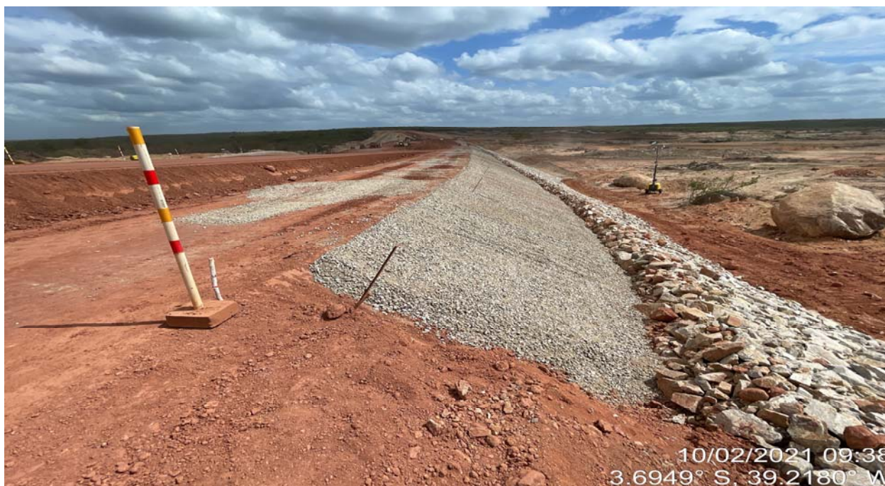
FOTO 54 Execução do rip – rap (Proteção de Montante)
