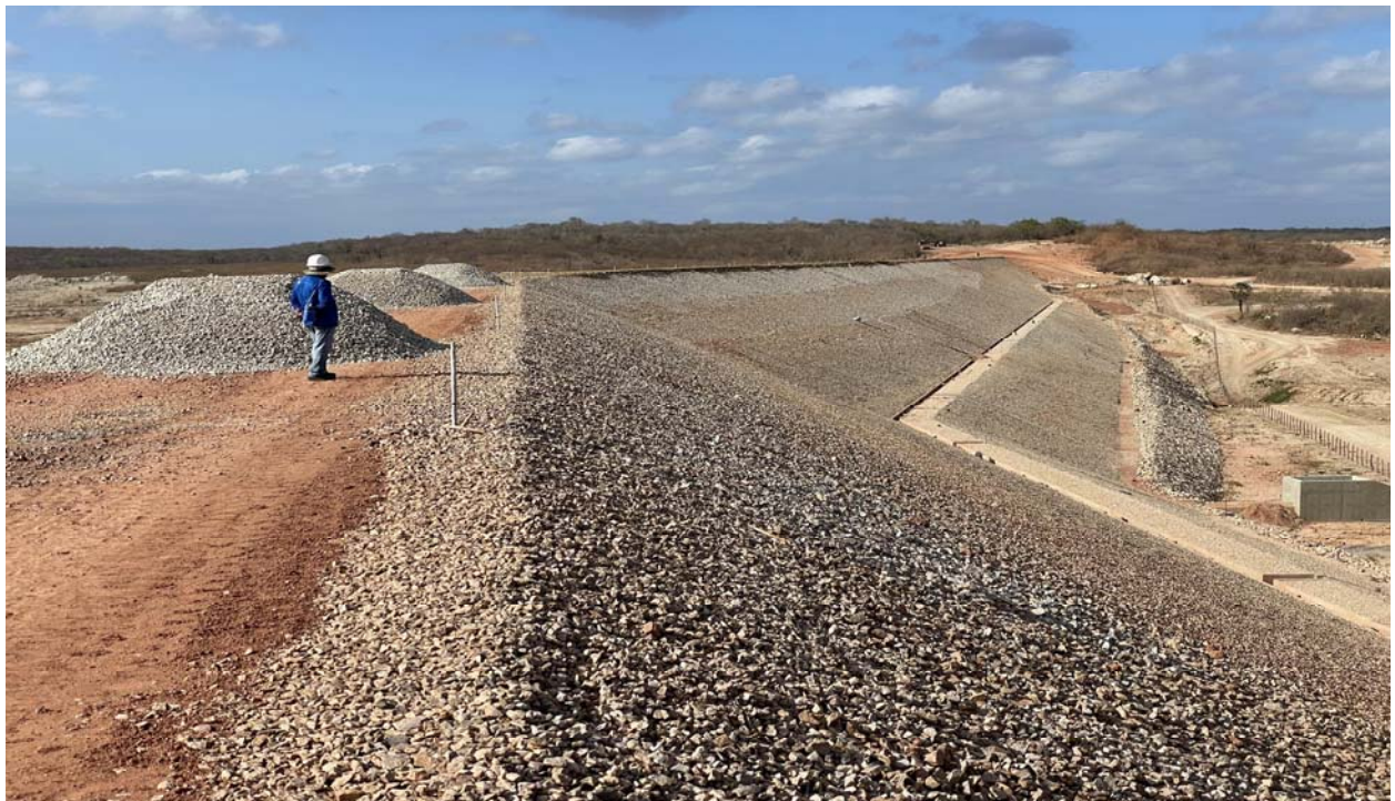
FOTO 146 - Execução do coroamento da barragem Melancia
