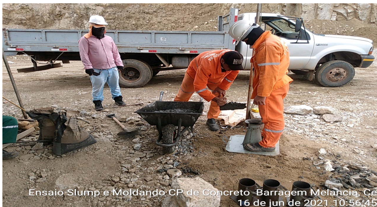
FOTO 106 - Ensaio do SLUMP TEST – Controle de qualidade do concreto
