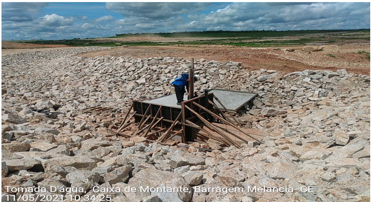
FOTO 92 – Tomada d'água - concretagem da caixa de montante
