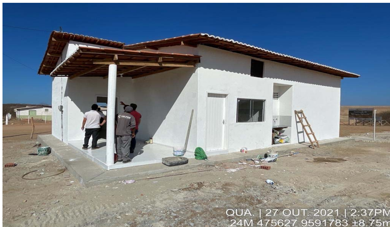
FOTO 159- Pintura externa e interna da casa do AGIR
