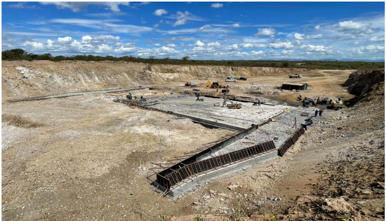
FOTO 116 - Vista panorâmica do vertedouro – concreto de regularização
