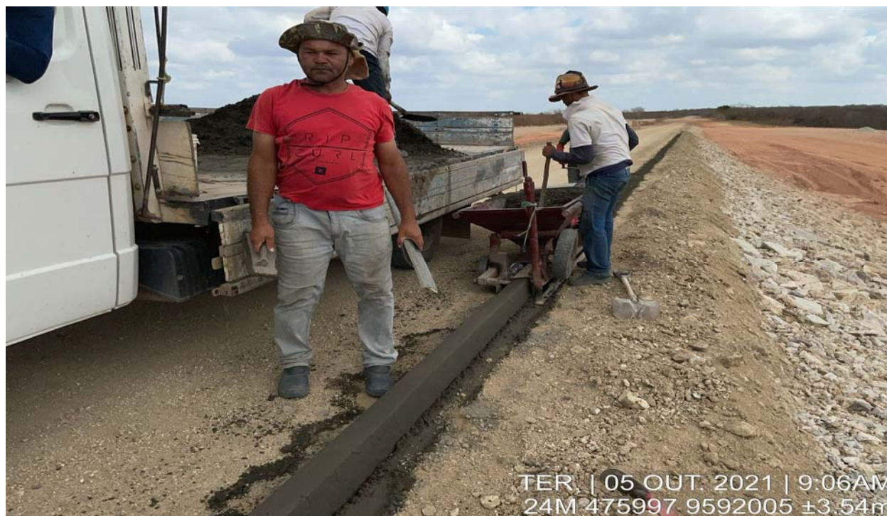
FOTO 151- Execução de meio fio da barragem Melancia
