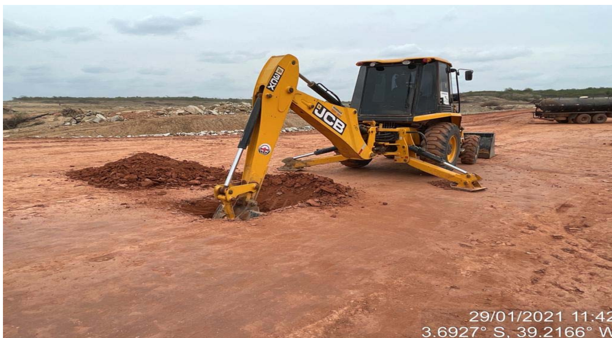
FOTO 48- Abertura de janela para inspeção da compactação do aterro (Vala 03)
