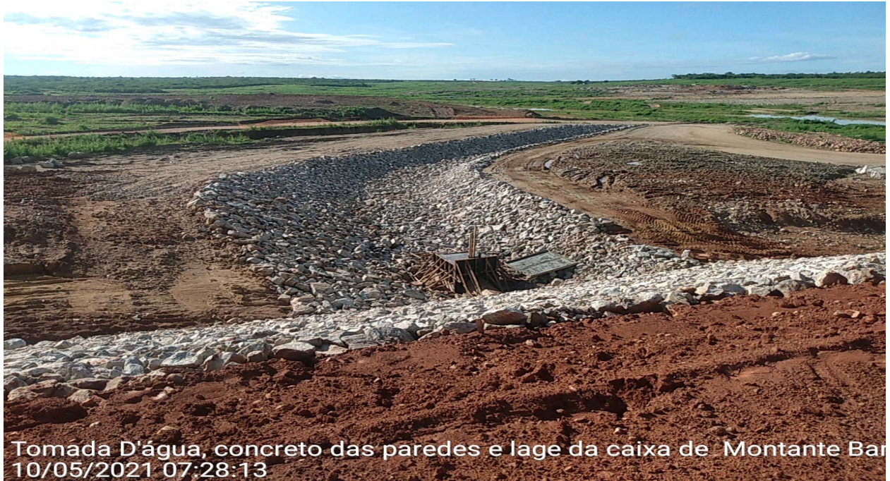
FOTO 91 – Tomada d'água - enrocamento no canal de aproximação— e concretagem da caixa de montante
