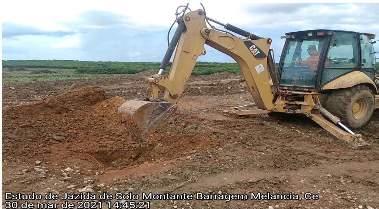
FOTO 73 - Sondagem no solo para avaliação de jazida na margem direita do riacho
