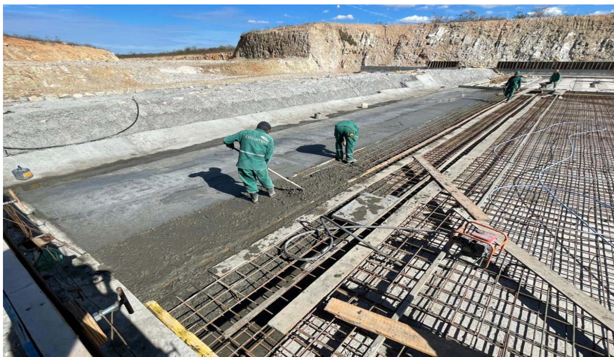
FOTO 130 – Concretagem da primeira etapa da laje da bacia de dissipação
