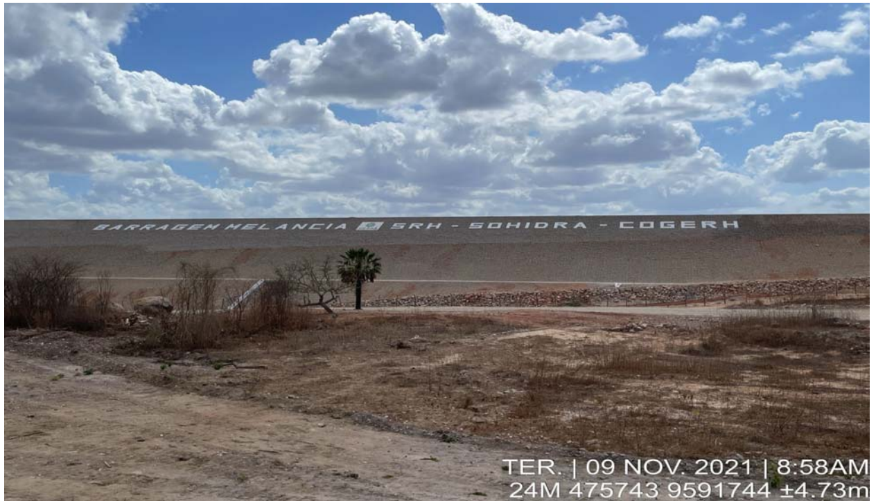
FOTO 179 - Vista de jusante da barragem Melancia.
