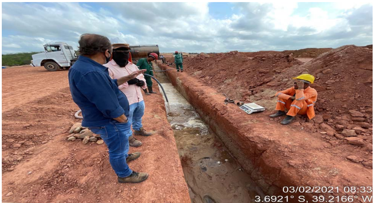
FOTO 52 – Adensamento do filtro vertical
