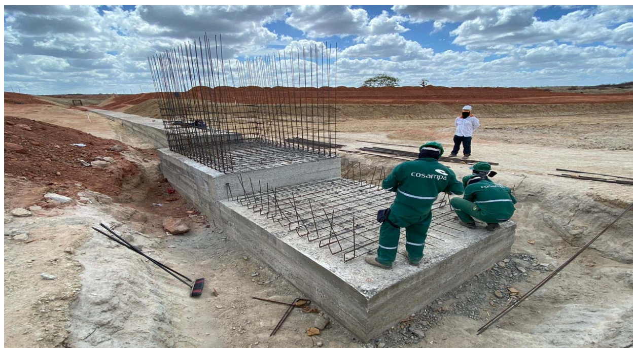
FOTO 26 - Armação da ferragem na caixa de jusante da tomada d'água (Est 11+15)
