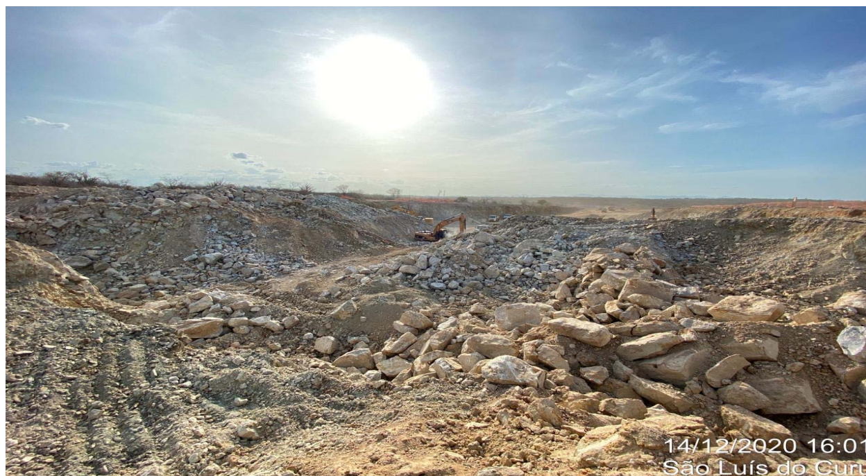
FOTO 27 – Escavação e transporte de rocha - material de 3º categoria (Est. 20 a 23)
