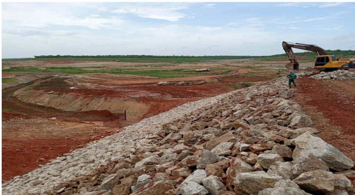
FOTO 77 – Execução do rip-rap (proteção de montante)
