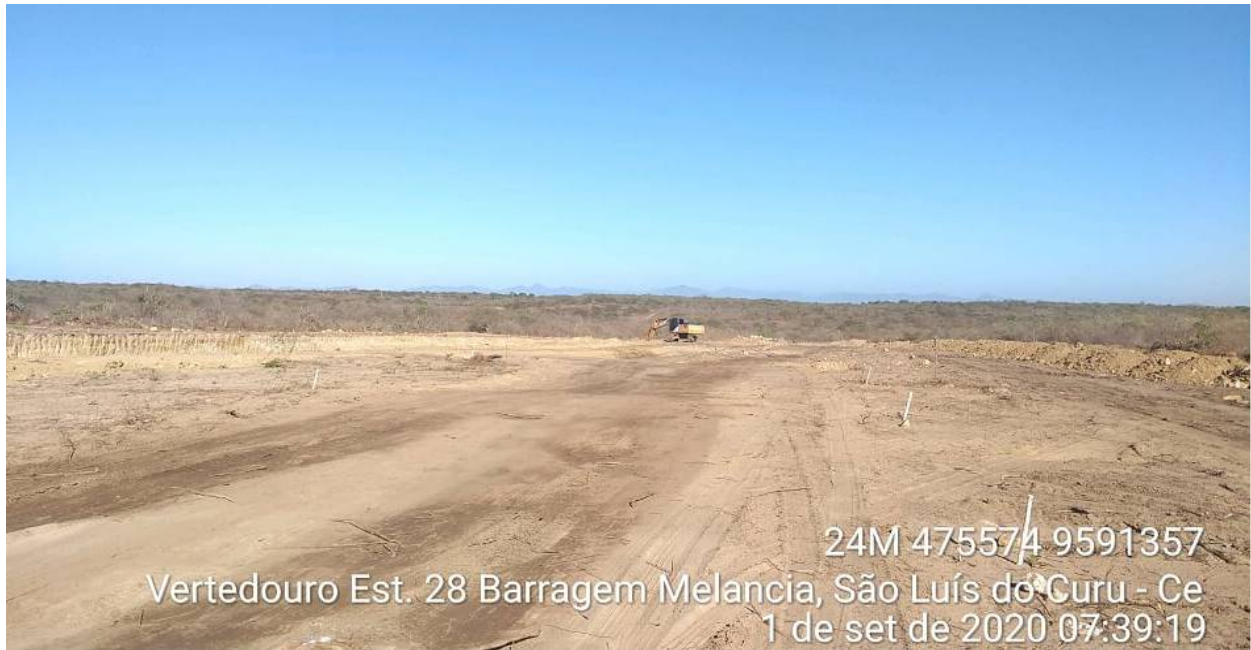
FOTO 01 – Escavação no vertedouro. (Est. 28)
