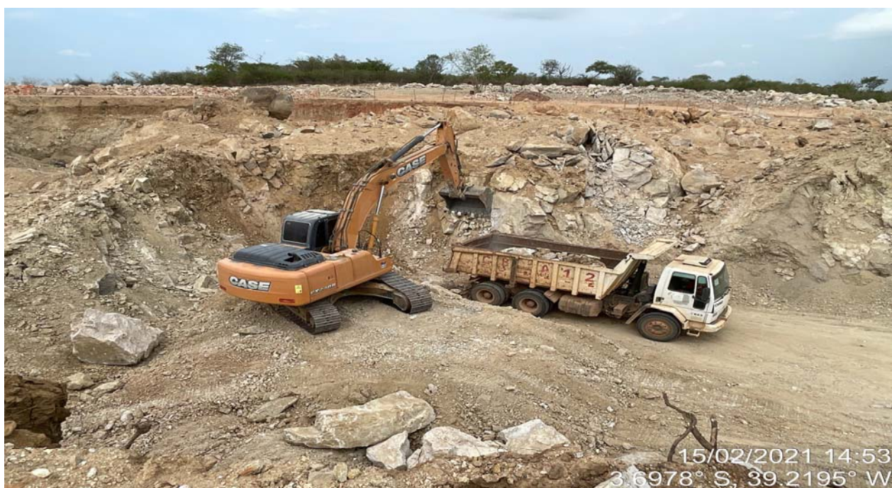
FOTO 58 – Escavação e transporte do material nas escavações do vertedouro
