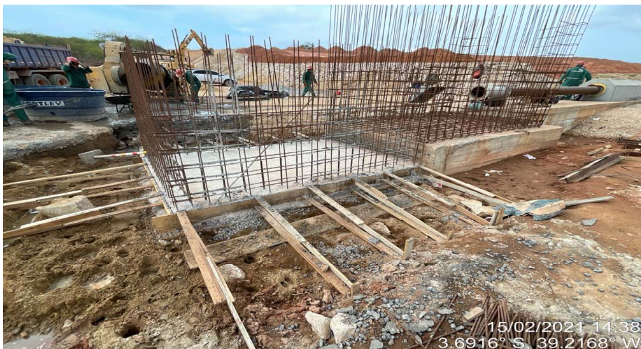
FOTO 57 – Concretagem da laje da caixa de jusante
