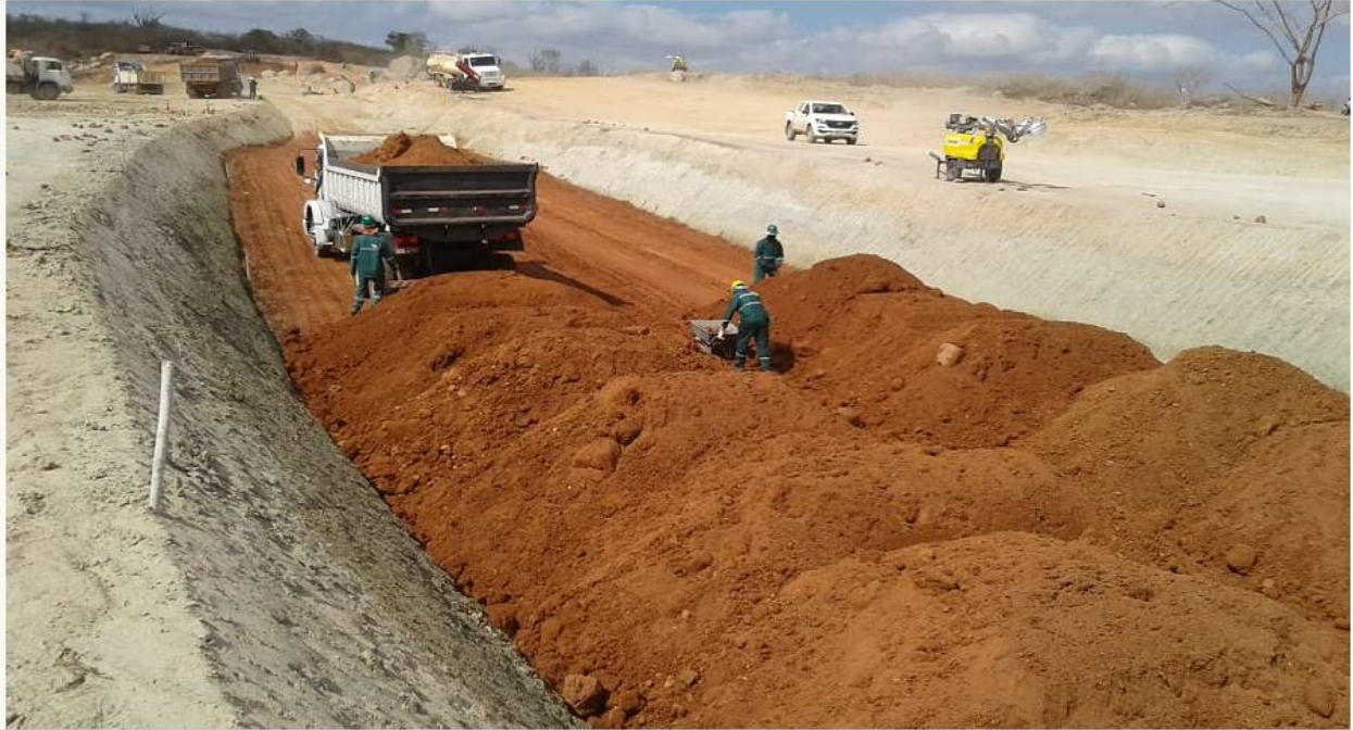
FOTO 07 – Lançamento de material no cut-off. (Est.14)
