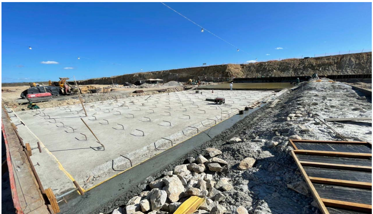
FOTO 132 - Limpeza na segunda etapa da laje da bacia de dissipação
