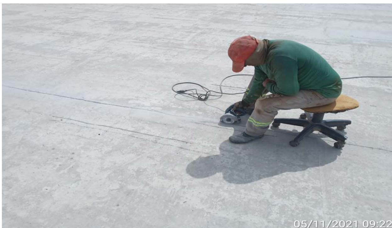
FOTO 166 – Execução de tratamento nas micro fissuras da laje da bacia de dissipação
