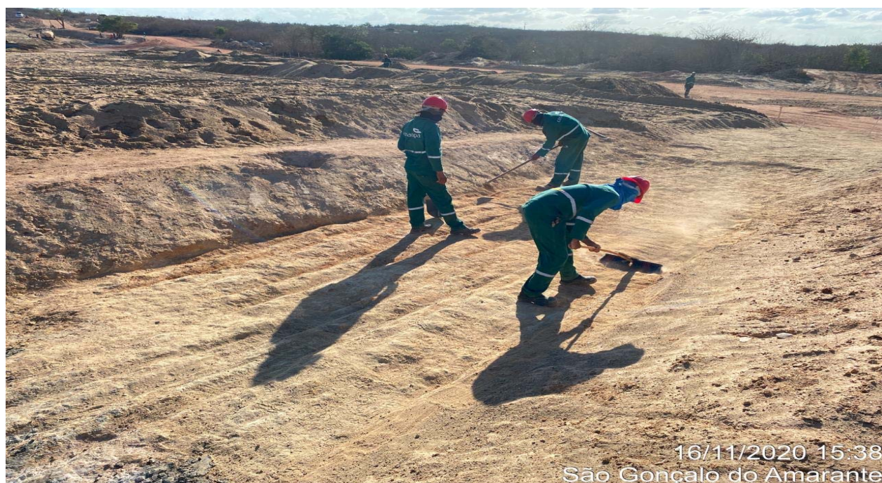
FOTO 20 - Limpeza da tomada d'água
