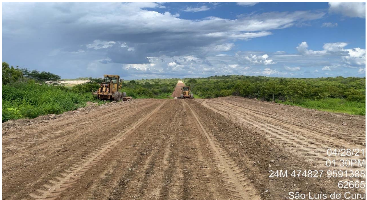
FOTO 82 - Execução da estrada de acesso ao vertedouro
