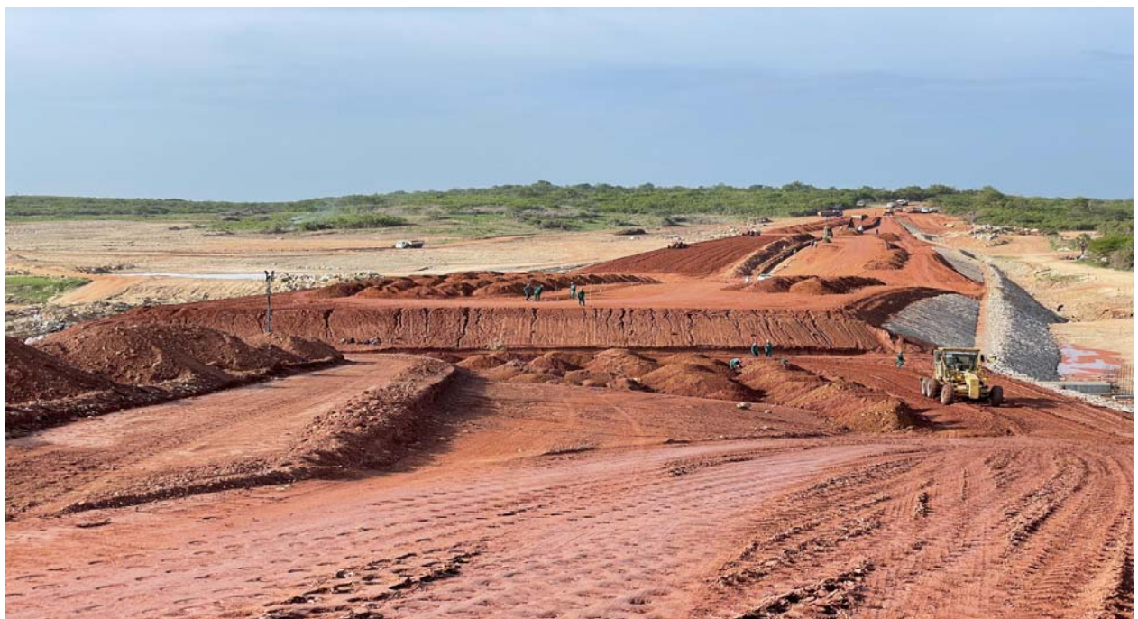
FOTO 63 – Escavação para execução do filtro vertical.
