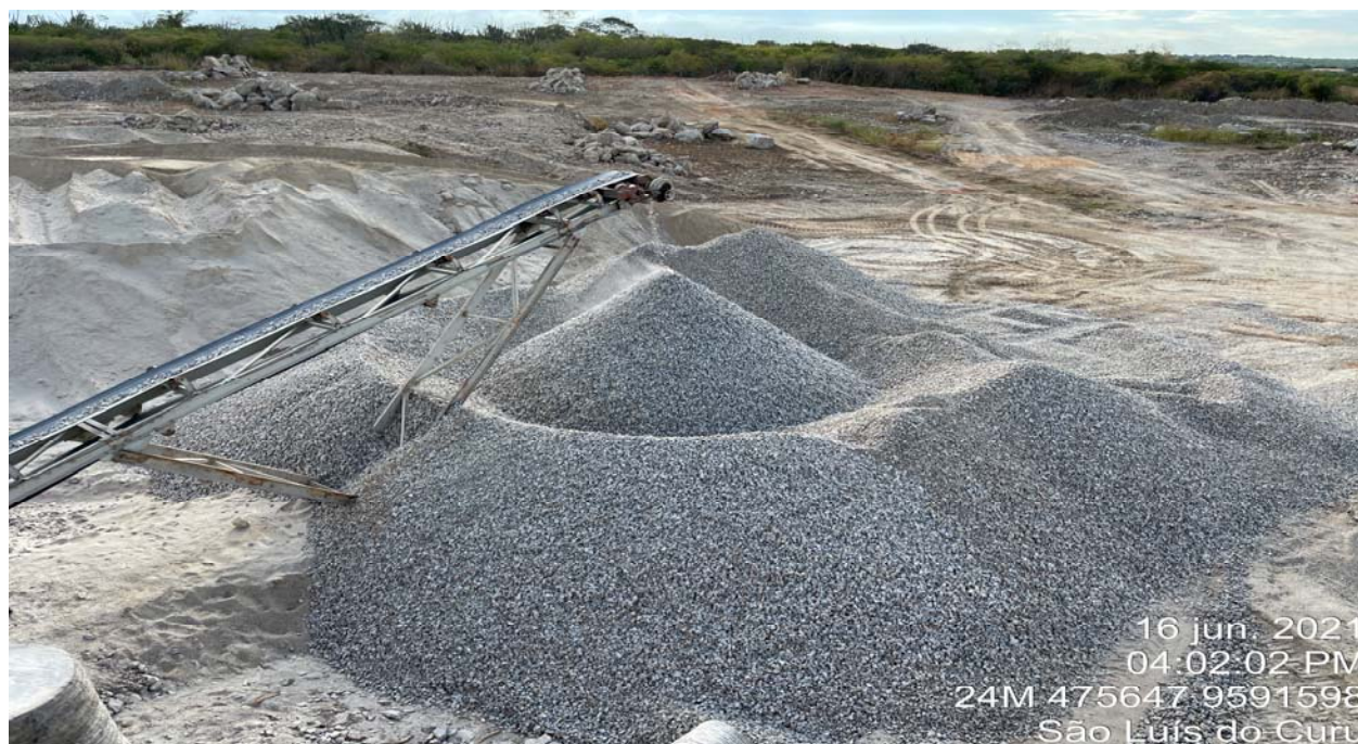
FOTO 105 - Inspeção de campo para verificação da qualidade dos materiais
