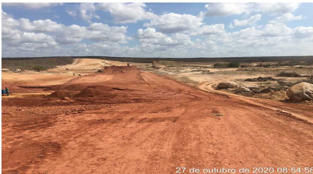
FOTO 10 - Vista da ombreira esquerda. (Est. 10)
