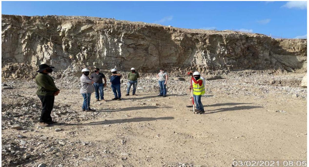
FOTO 51 – Inspeção nas escavações do vertedouro
