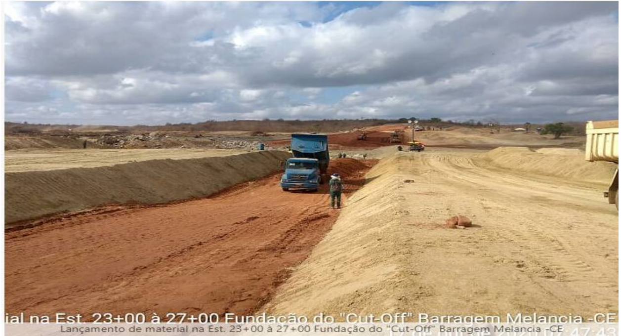
FOTO 13 - Lançamento de material no barramento principal. (Est.23 a 27)
