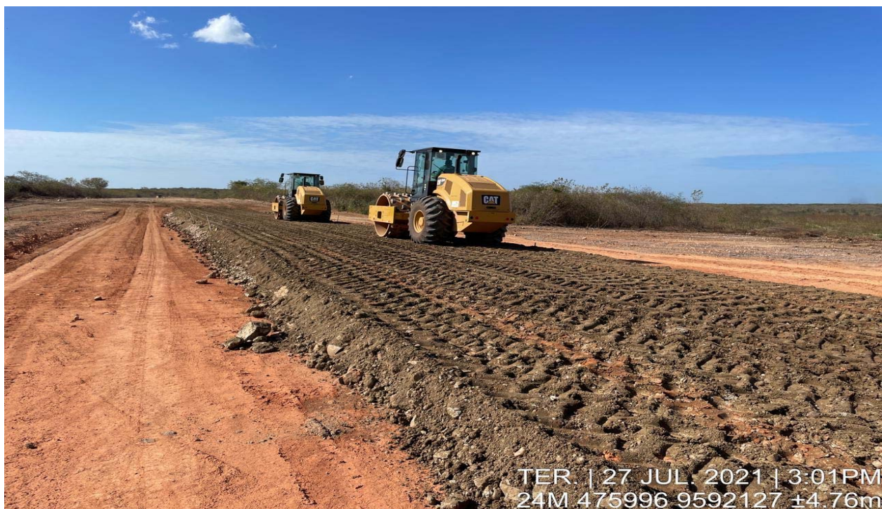
FOTO 121 - Coroamento e compactação da barragem auxiliar 02
