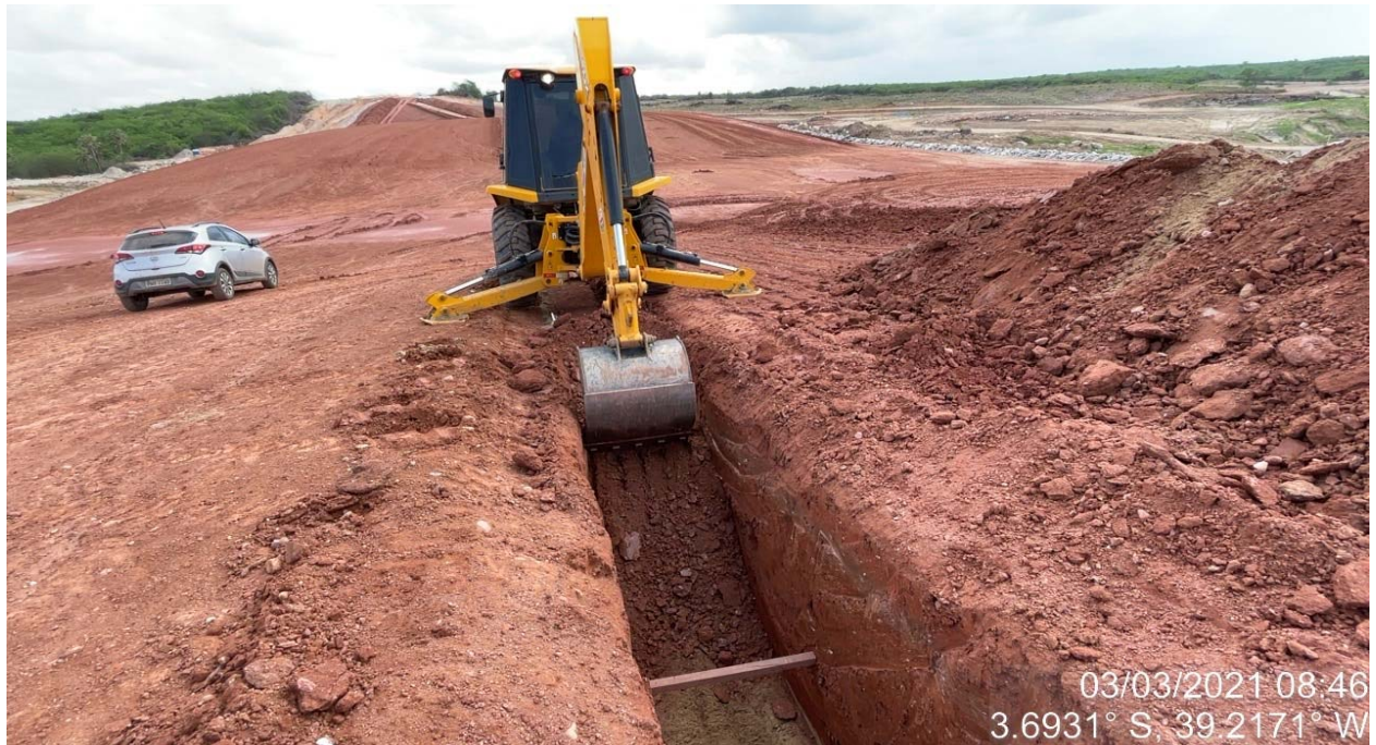
FOTO 63 – Escavação para execução do filtro vertical.
