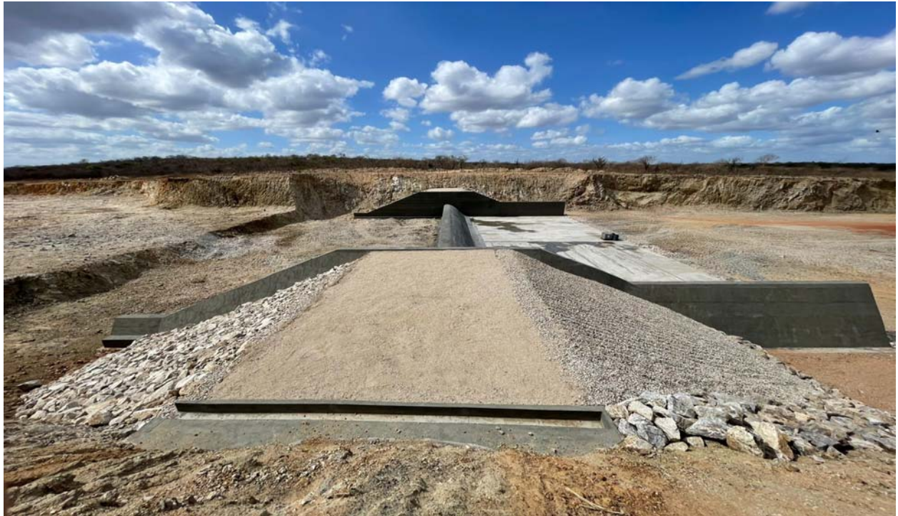
FOTO 175 - Vista do vertedouro.
