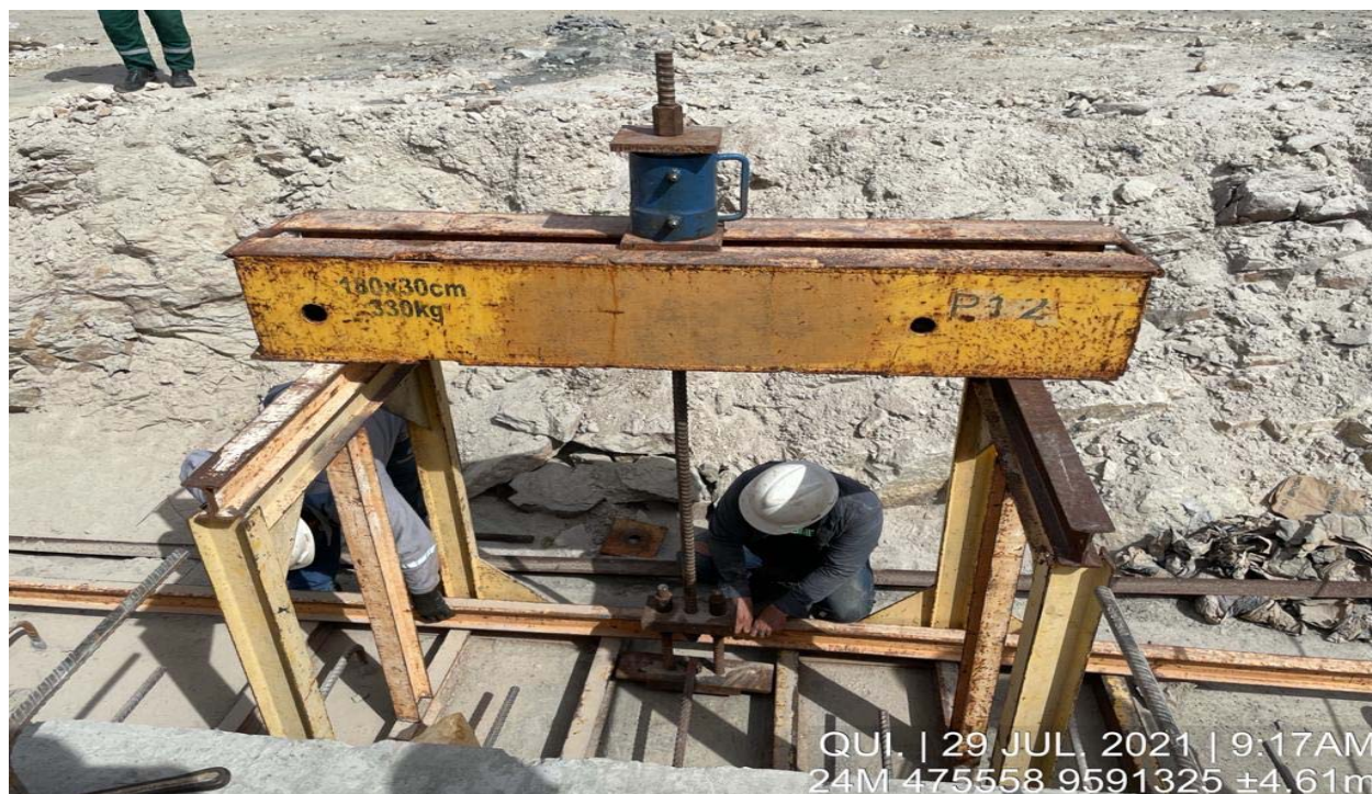
FOTO 123 - Teste de carga nos chumbadores da laje da bacia de dissipação.
