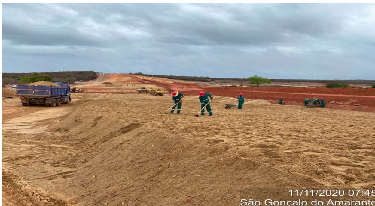
FOTO 18 - Lançamento do filtro horizontal – jusante do barramento principal
