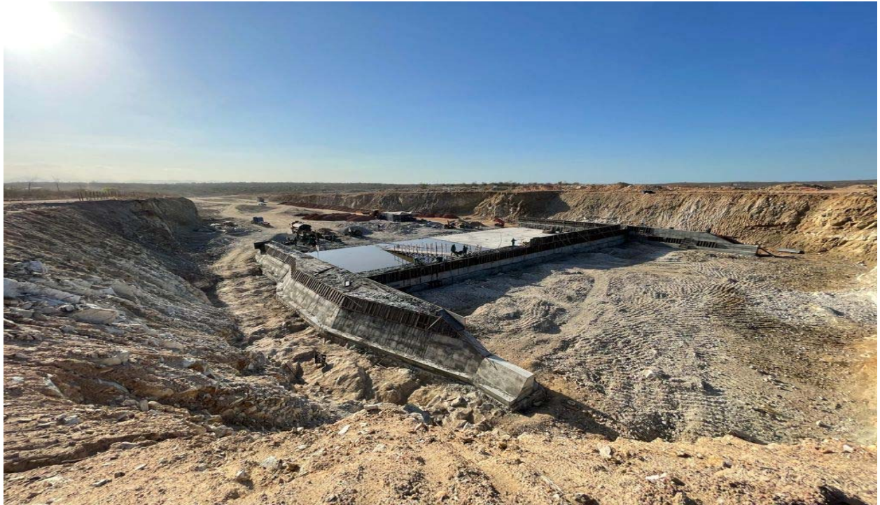
FOTO 141 - Vista panorâmica do vertedouro (lado esquerdo)
