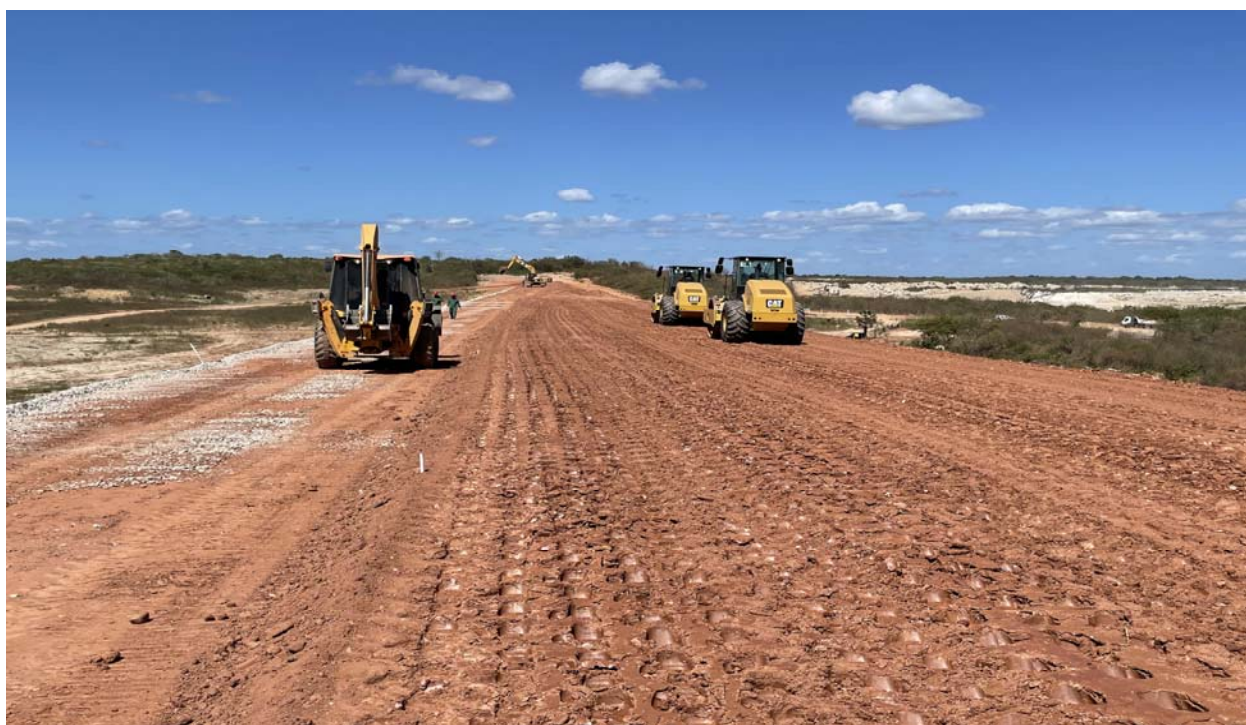
FOTO 118 - Compactação do material – maciço
