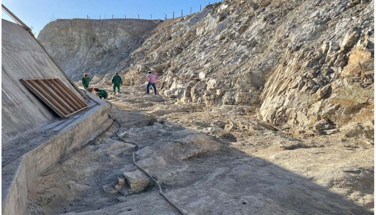
FOTO 147 – Execução do tratamento na fundação para aterro do muro lateral esquerdo (vertedouro)
