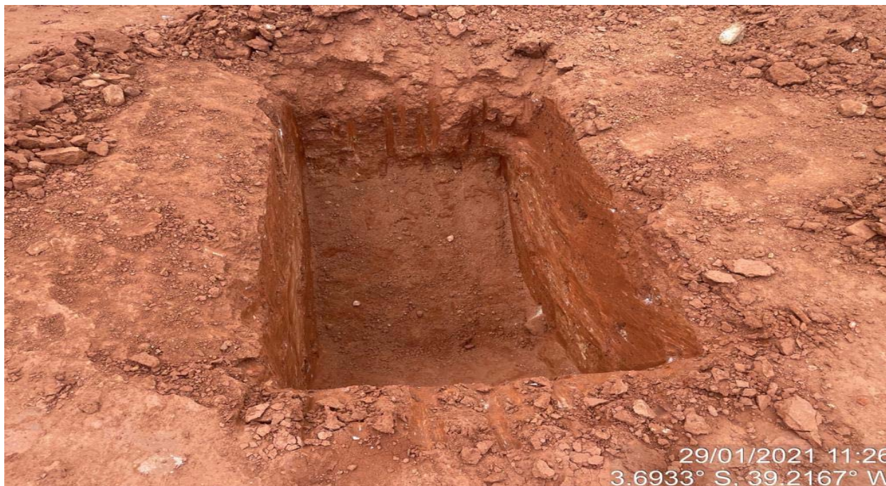
FOTO 47- Abertura de janela para inspeção da compactação do aterro (Vala 01)
