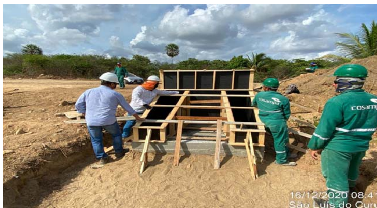
FOTO 30 – Execução de Forma para concretagem das alas (Bueiro 03)
