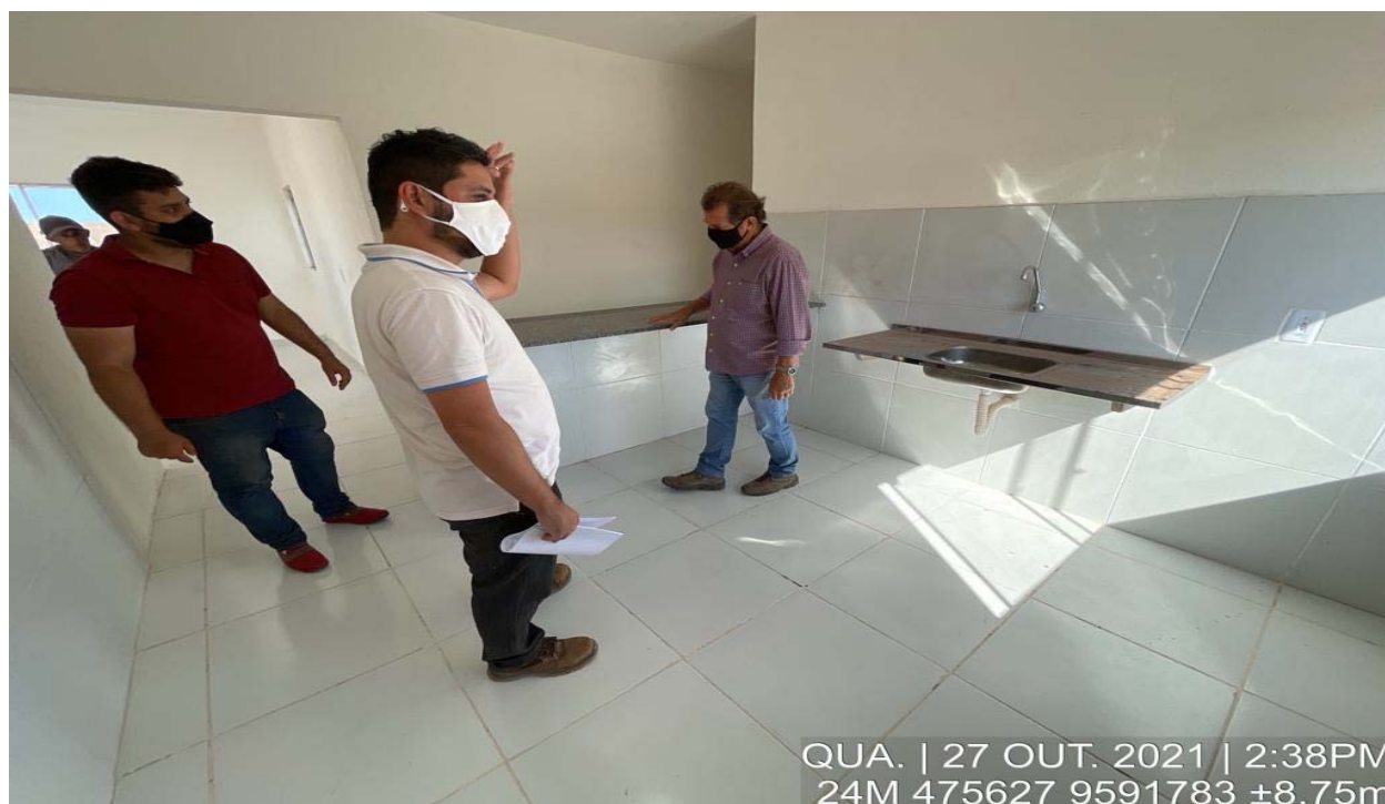
FOTO 158- Inspeção técnica na casa do AGIR
