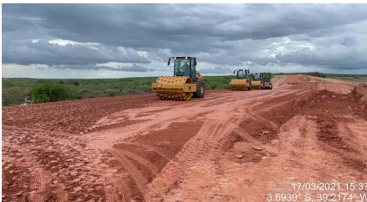
FOTO 68 – Compactação de material no maciço
