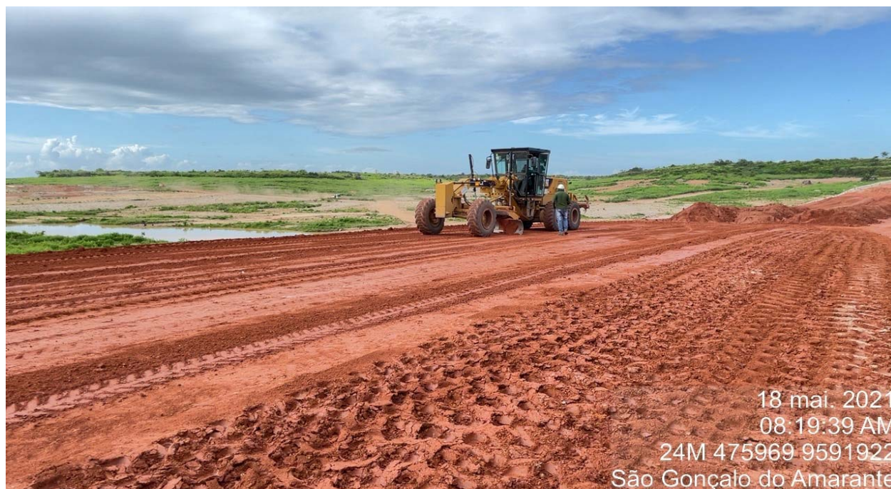
FOTO 93 - Execução de tratamento do material (montante do barramento)
