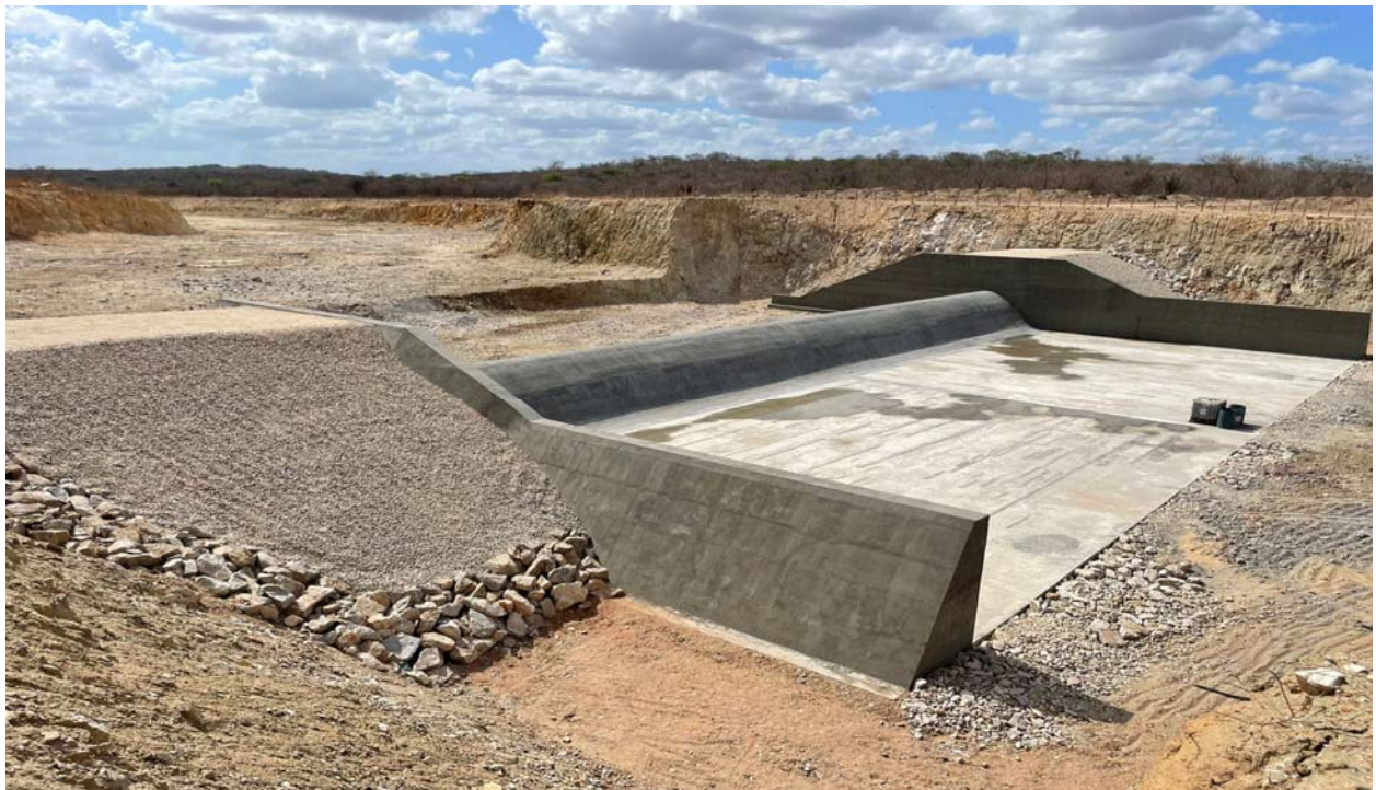
FOTO 176 - Vista do vertedouro.
