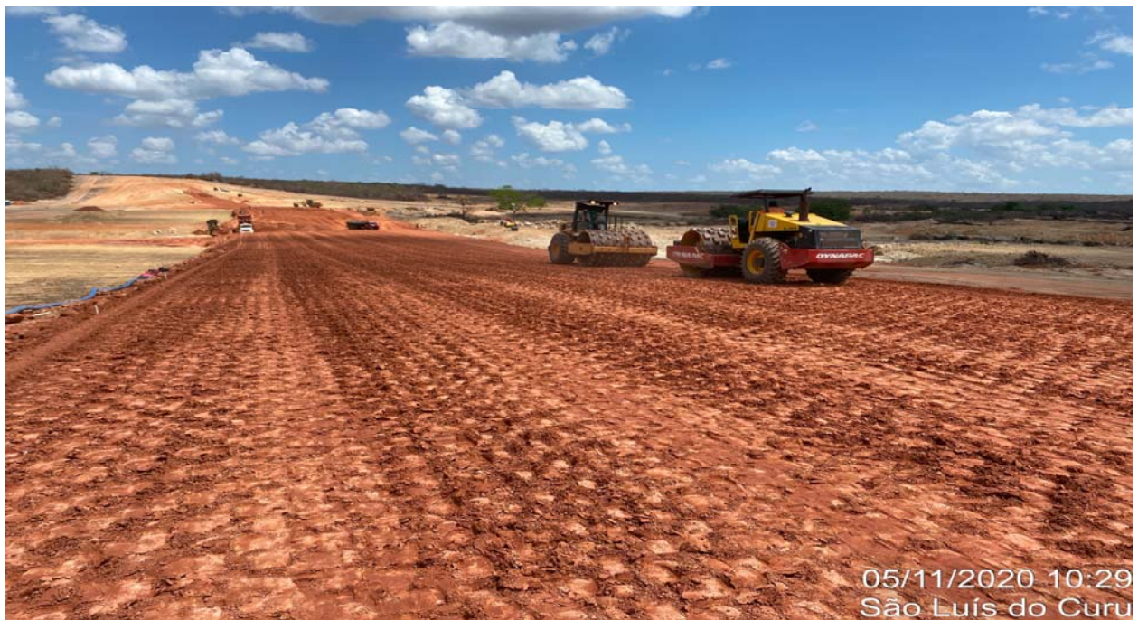
FOTO 16 – Compactação do material no cut-off (Est.-10 a 18)
