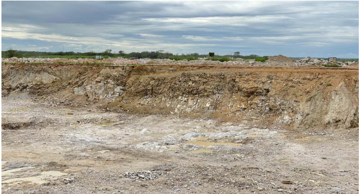
FOTO 85 - Vista do corte da escavação na região do muro ala. (margem direita)
