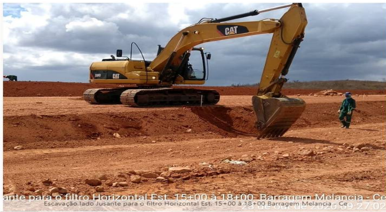
FOTO 11 – Corte para execução do filtro horizontal. (Est. 15 a 18)
