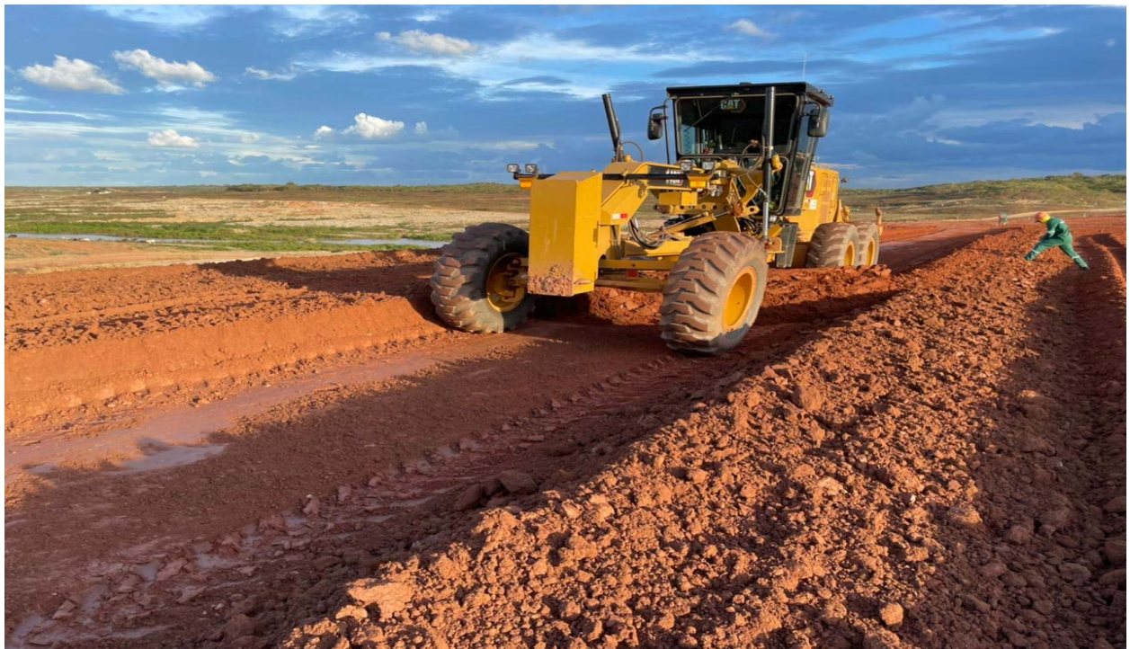
FOTO 114 - Tratamento do material – maciço
