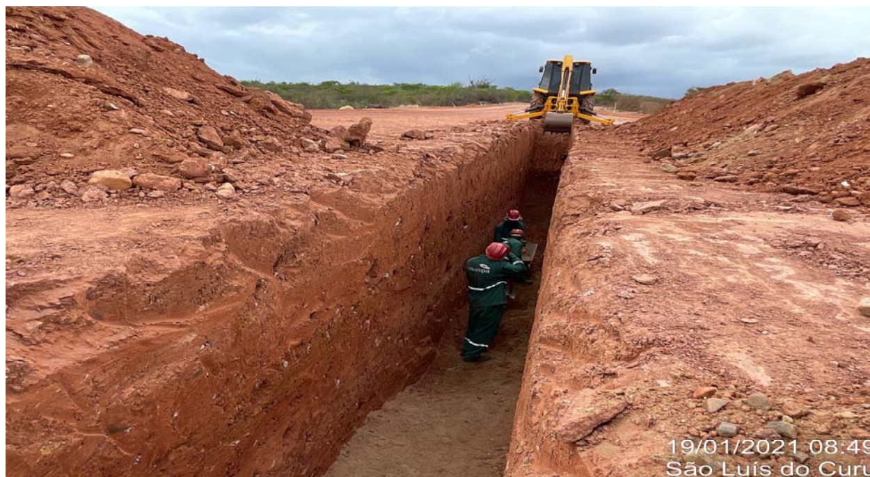
FOTO 41- Escavação do maciço para execução do filtro vertical
