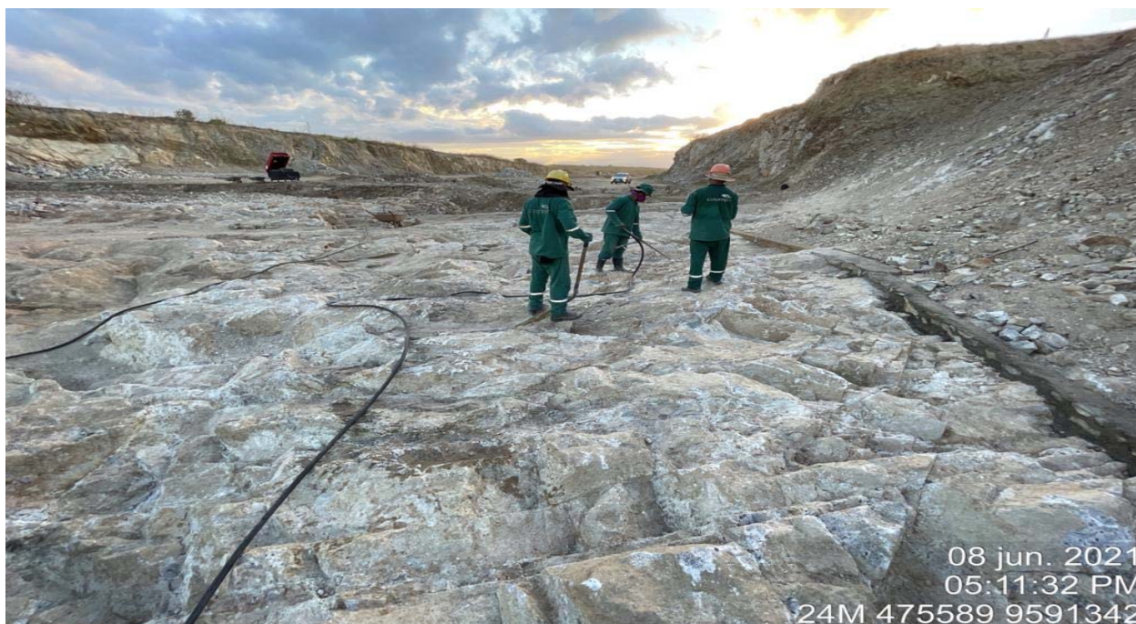
FOTO 99 – Limpeza fina e remoção de rochas soltas – fundação do vertedouro
