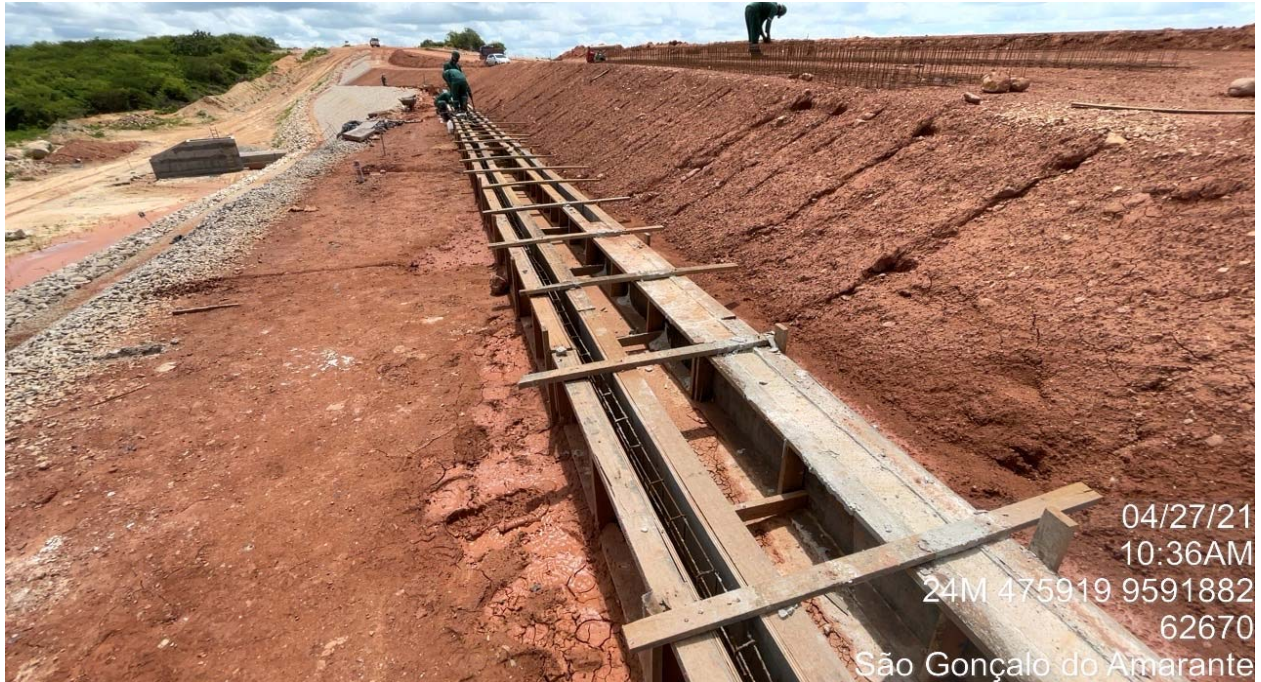
FOTO 79 - Execução das formas das canaletas (Berma)
