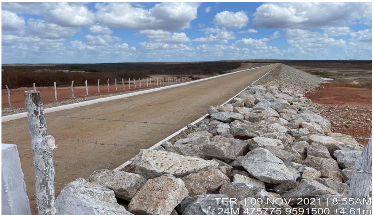
FOTO 178 - Vista da barragem Melancia. (ombreira direita)
