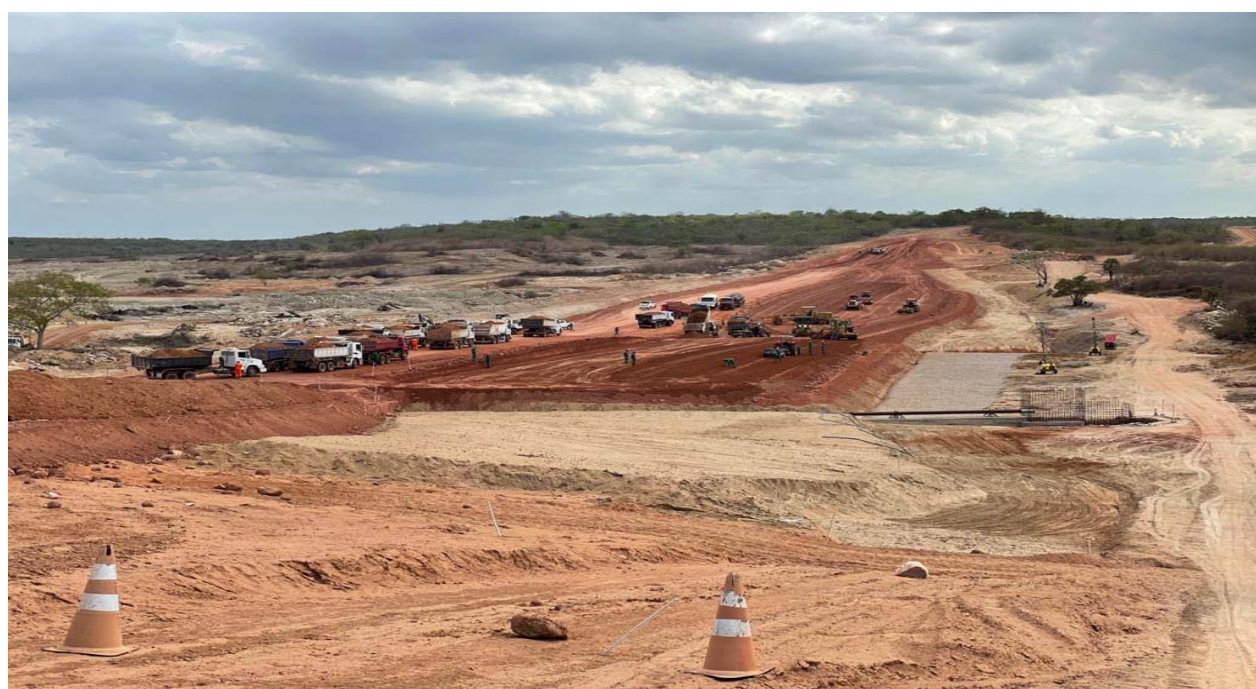
FOTO 36- Vista Panorâmica da evolução da obra – barragem Melancia
