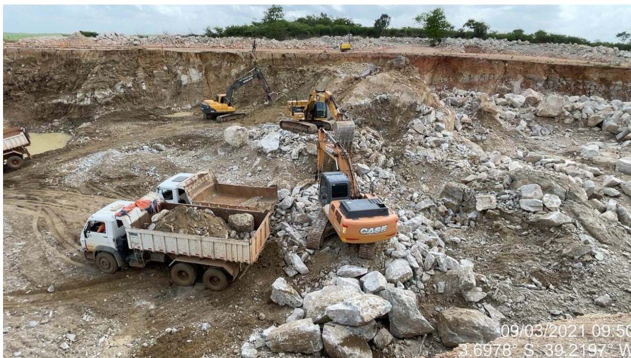
FOTO 65- Escavação e transporte do material nas escavações do vertedouro.
