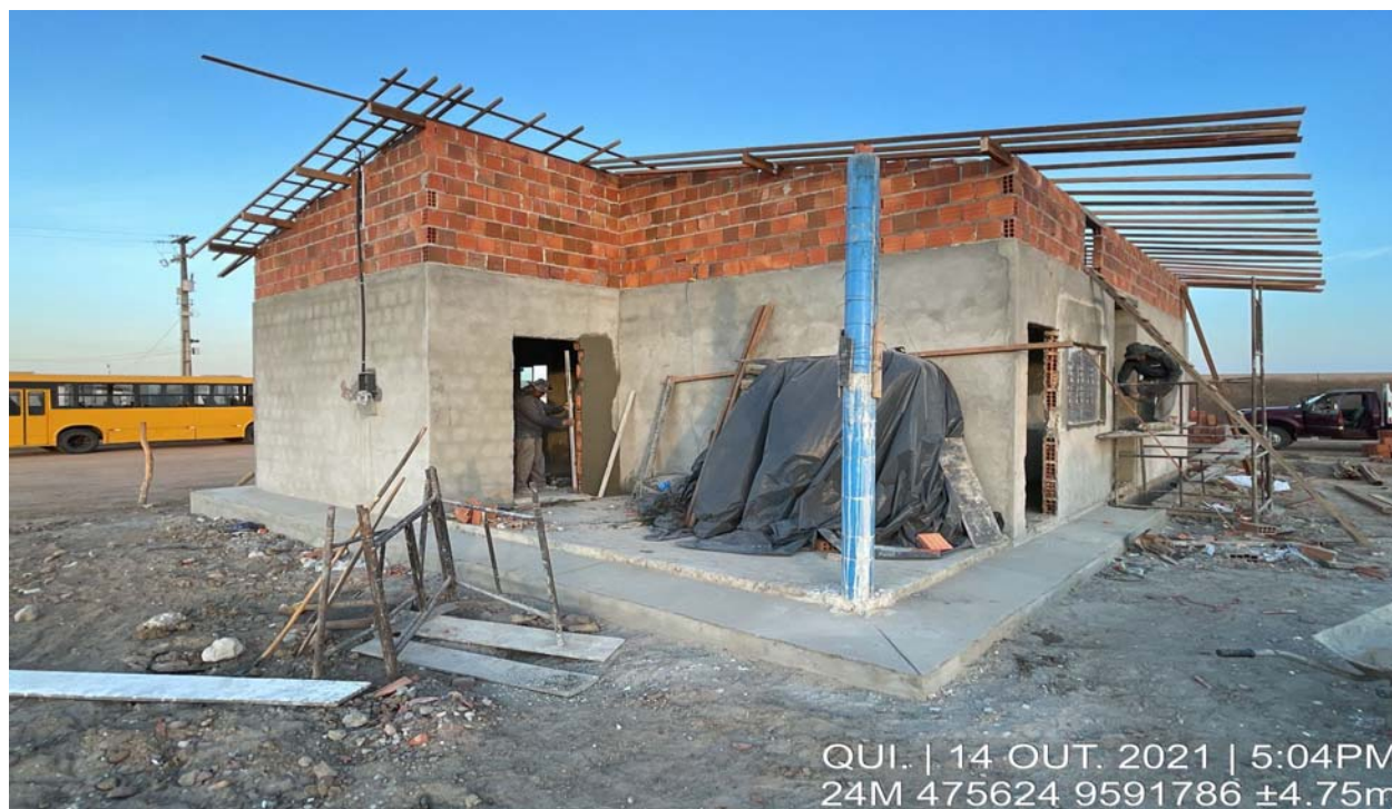
FOTO 153- Execução de cobertura da casa do AGIR
