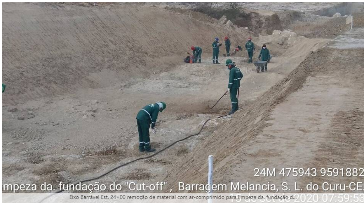
FOTO 05 – Limpeza manual na fundação do barramento principal. (Est.24)
