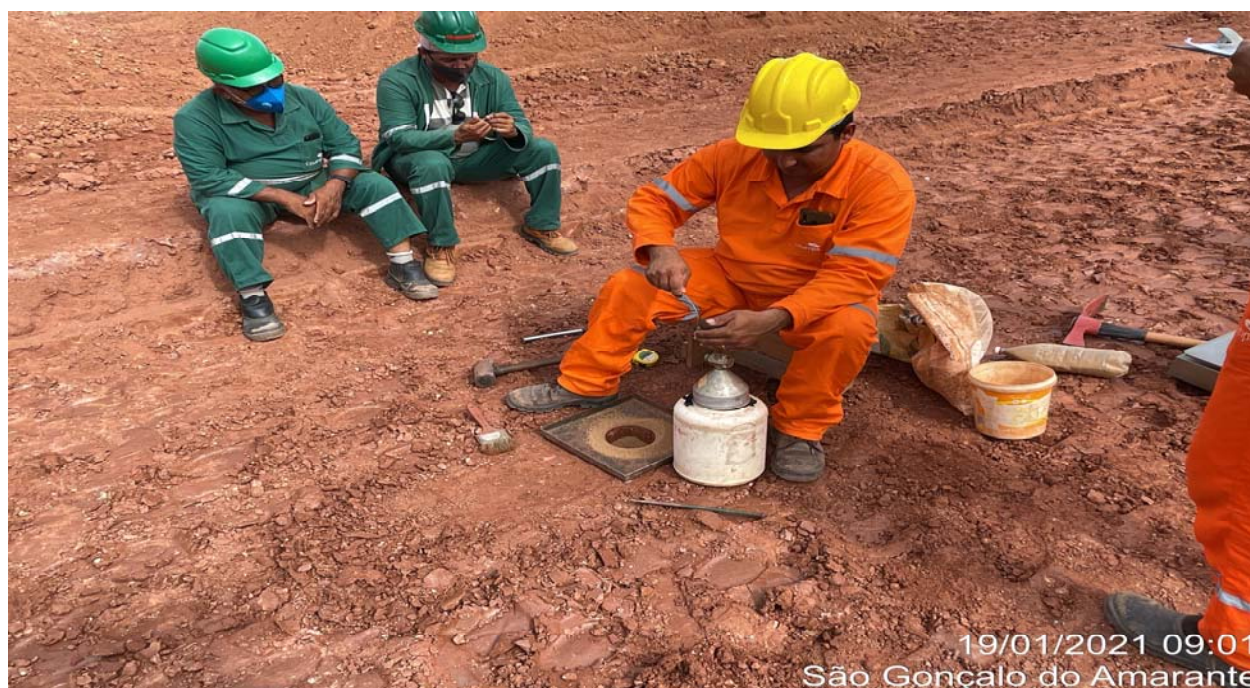
FOTO 42- Ensaio de compactação – In situ
