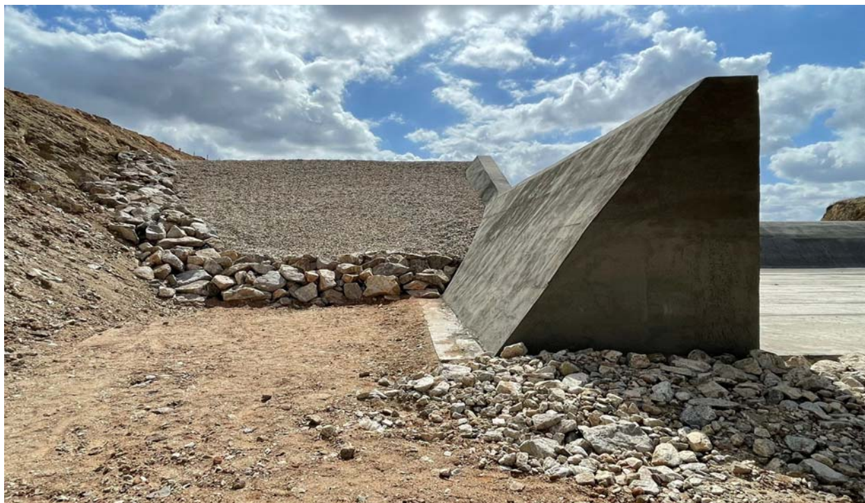
FOTO 173 - Aterro do muro lateral direito.
