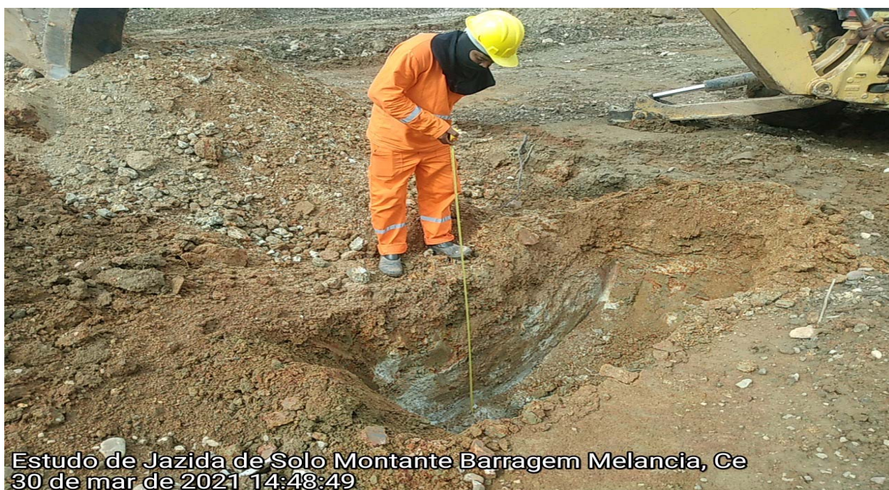
FOTO 74 - Sondagem no solo para avaliação de jazida na margem direita do riacho
