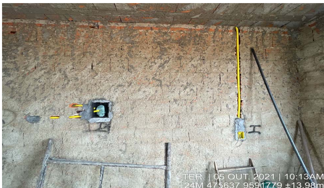
FOTO 150- Execução das instalações elétrica da casa do AGIR
