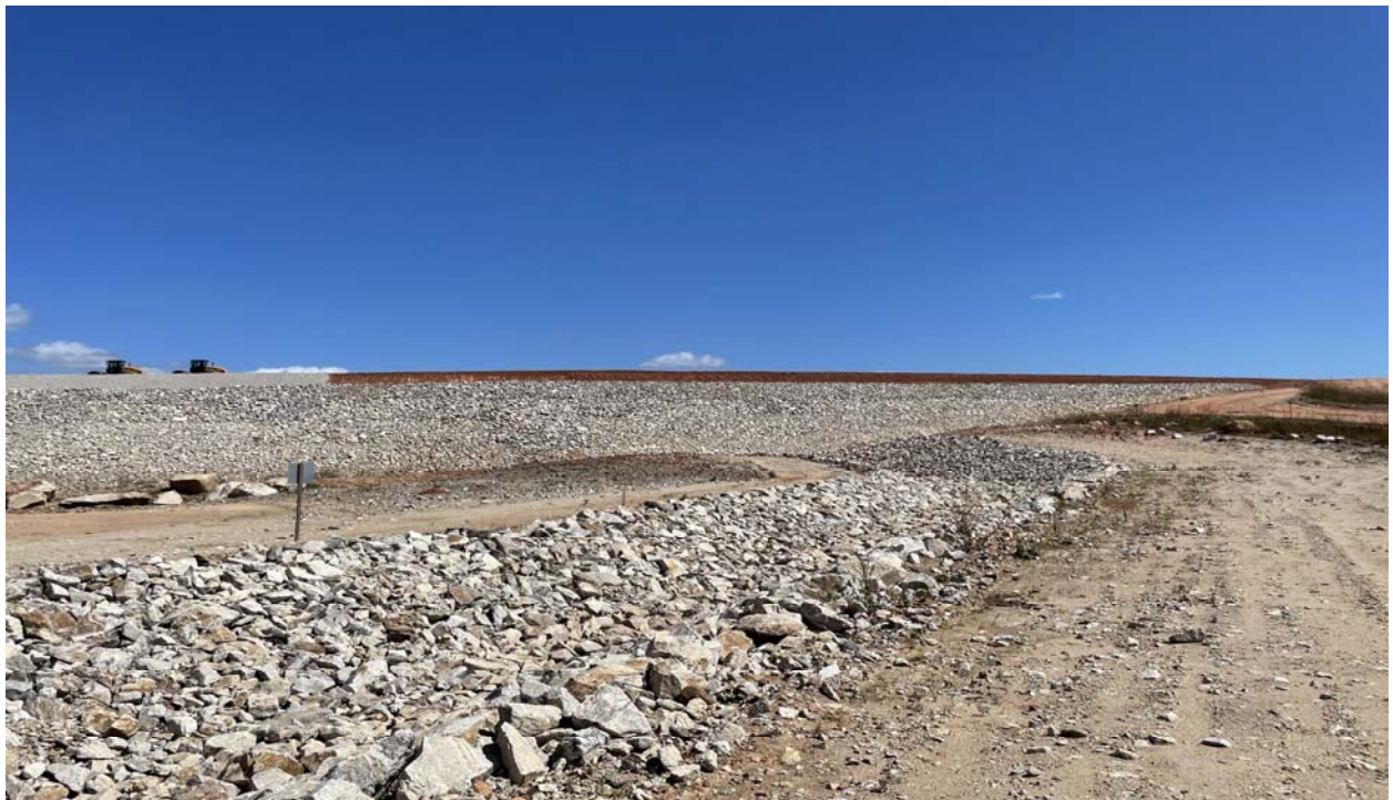
FOTO 120 - Canal de aproximação – tomada d'água
