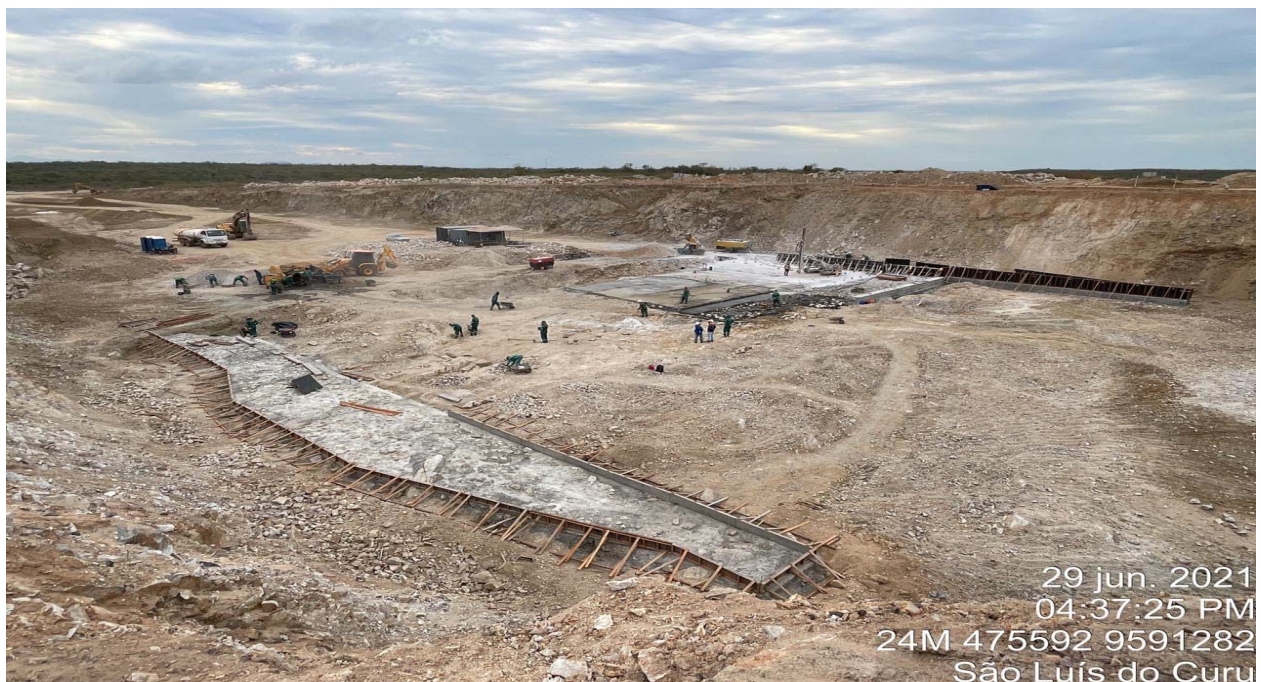
FOTO 112 - Concreto de regularização do muro lateral esquerdo (concreto ciclópico Fck=15mpa)
