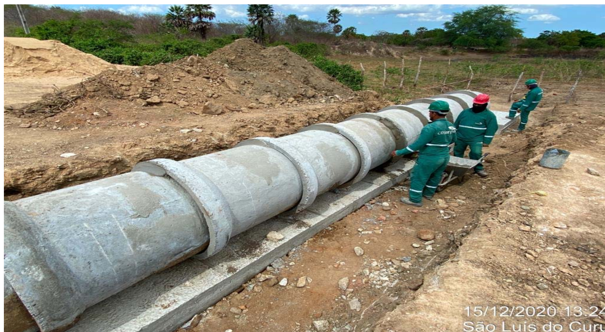
FOTO 29 – Bueiro 03 - Rejunte dos tubos de concreto com argamassa de cimento e areia (1;4)
