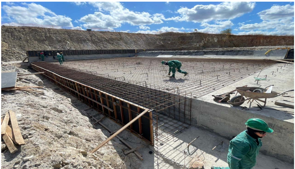
FOTO 125 – Execução de forma para concretagem do redente (laje da bacia de dissipação)
