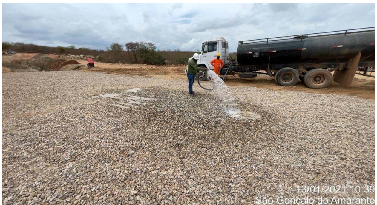
FOTO 38 – Teste de Infiltração na transição do rock Fill
