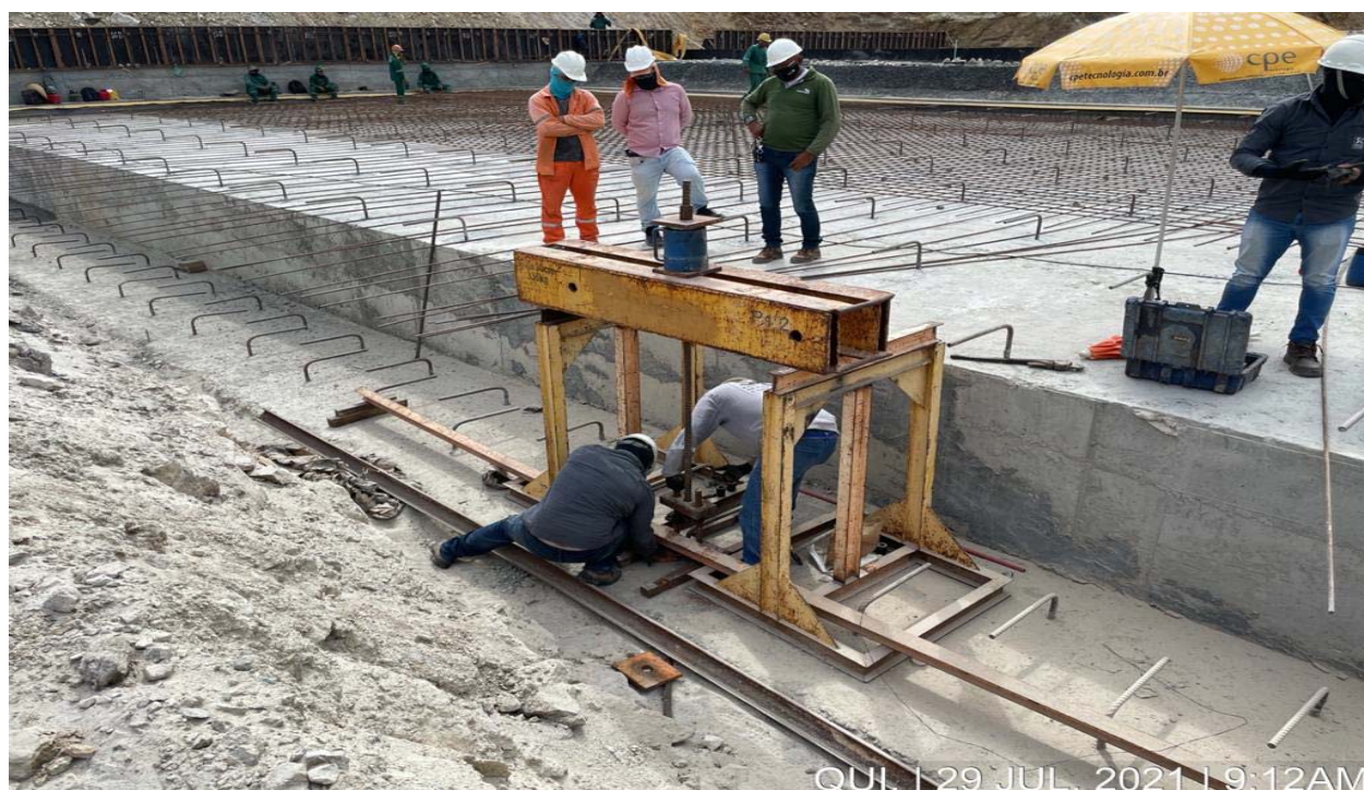
FOTO 124 - Teste de carga nos chumbadores da bacia de dissipação.
