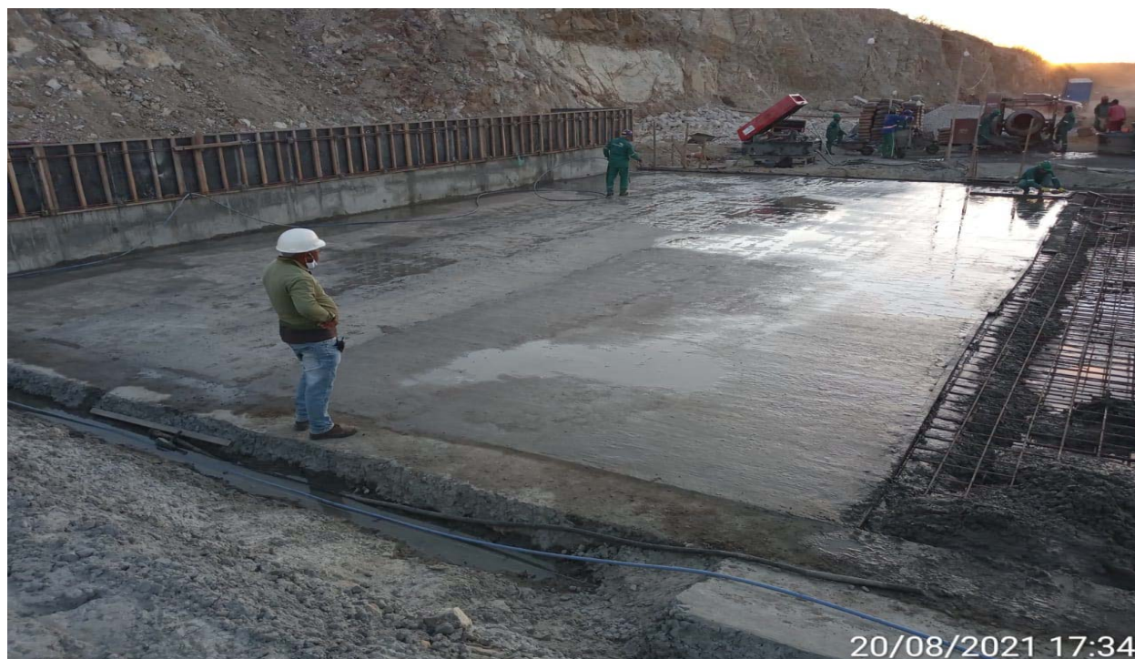
FOTO 139 - Concretagem da segunda etapa da laje da bacia de dissipação
