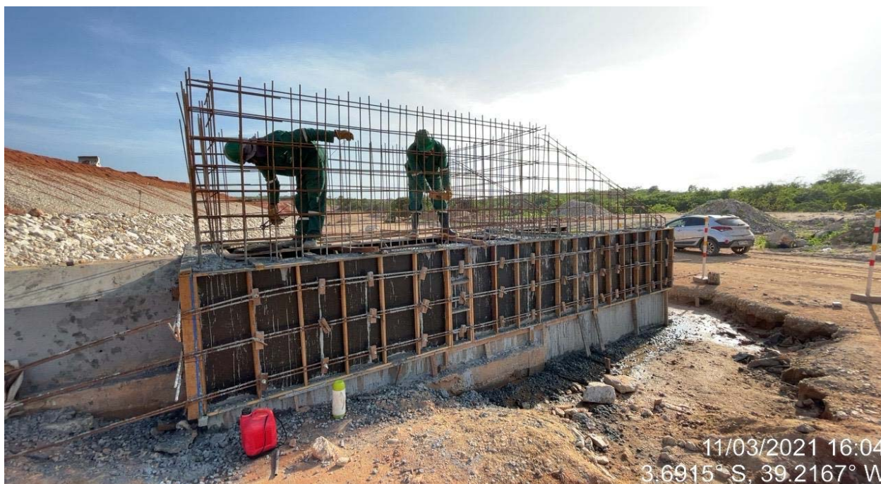
FOTO 66 - Armação da ferragem na caixa de jusante – tomada d'água
