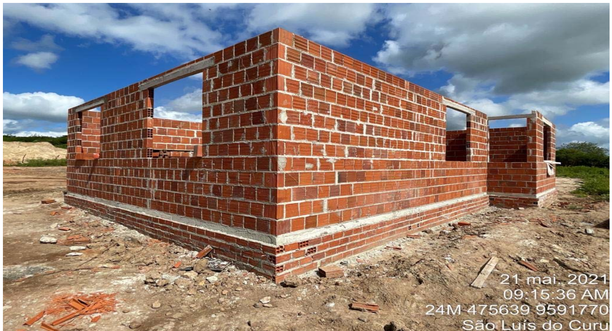
FOTO 96 - Execução de alvenaria de elevação – casa do AGIR
