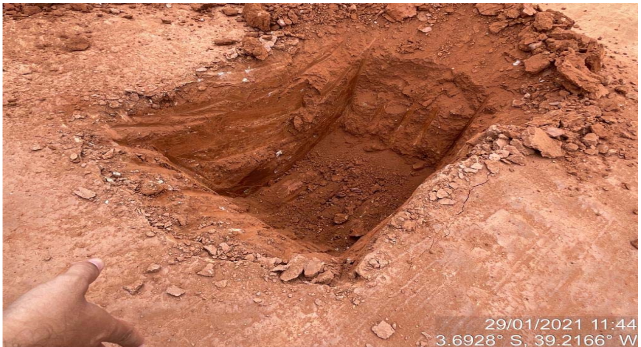
FOTO 50- Abertura de janela para inspeção da compactação do aterro (Vala 03)
