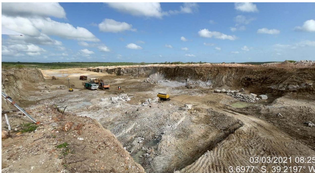
FOTO 62 - Vertedouro – perfuração de rocha com emprego do rock-drill
