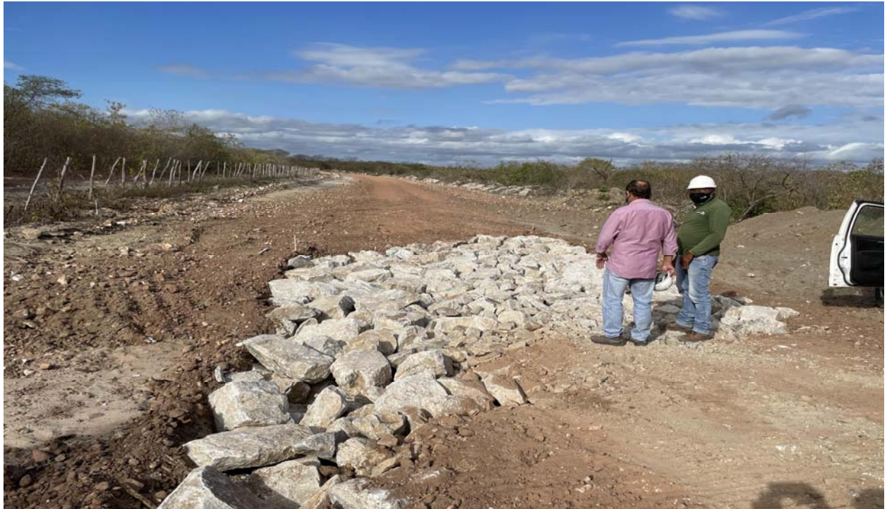
FOTO 131 - Execução de enrocamento nas estradas de acesso
