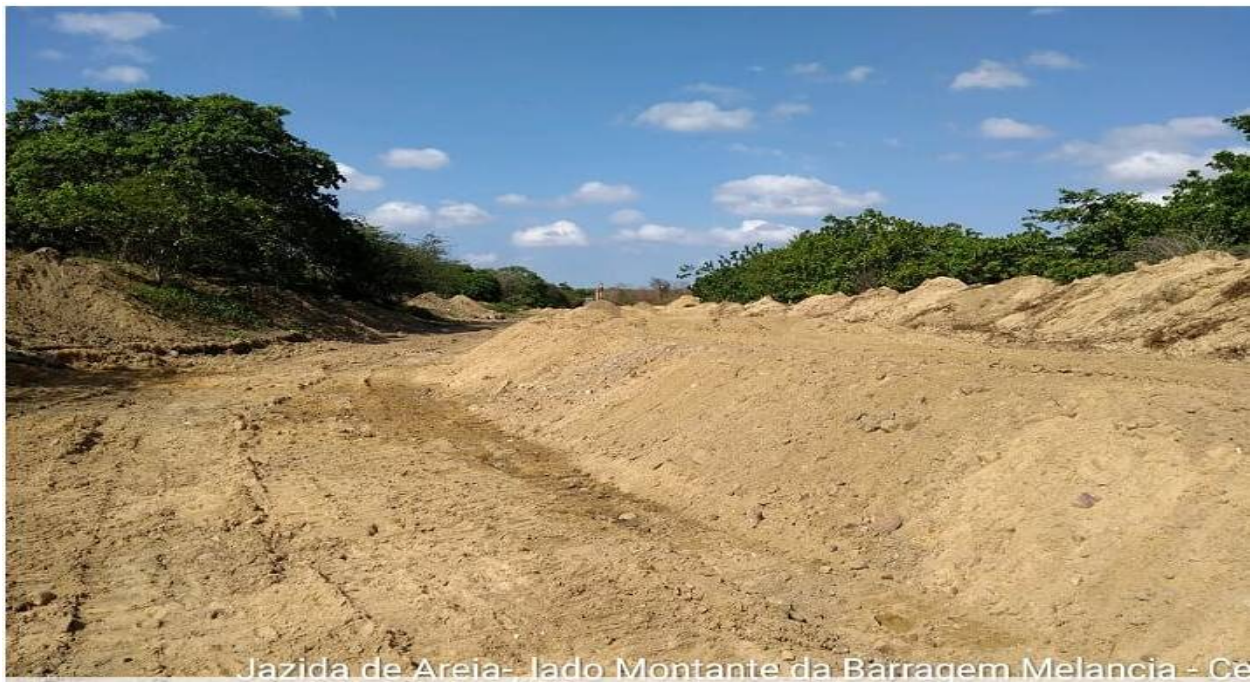
FOTO 14 - Vista do areal a montante do barramento.
