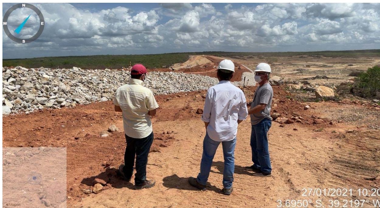
FOTO 45 Visita do Engenheiro da Caixa Econômica Federal.
