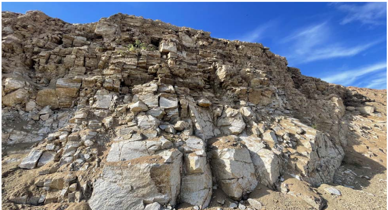
FOTO 86 – Vista do corte da escavação na região do Creager. (margem direita.)
