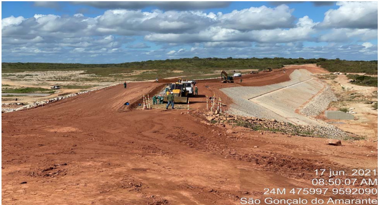
FOTO 110 - Vista panorâmica da barragem Melancia – ombreia direita
