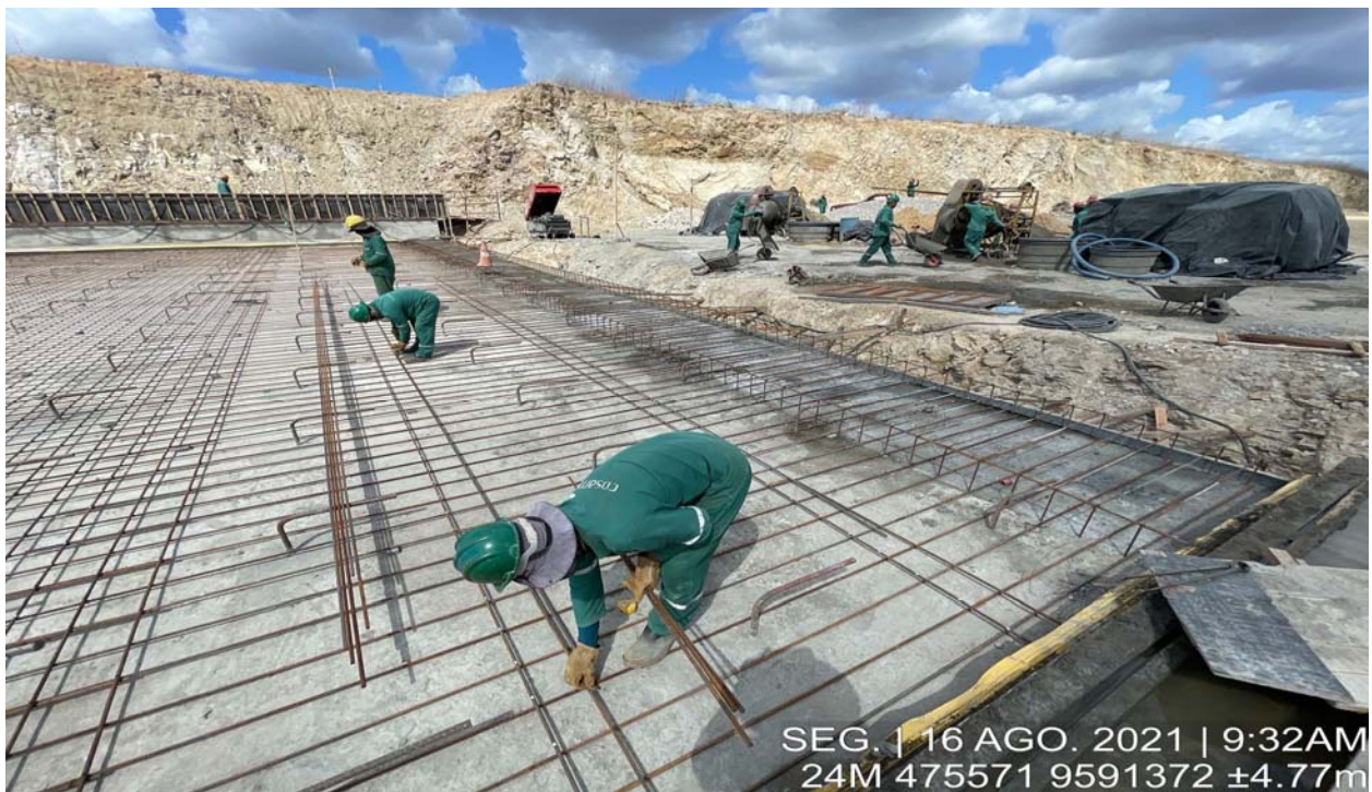
FOTO 136 - Armação da ferragem da laje da bacia de dissipação (segunda etapa)
