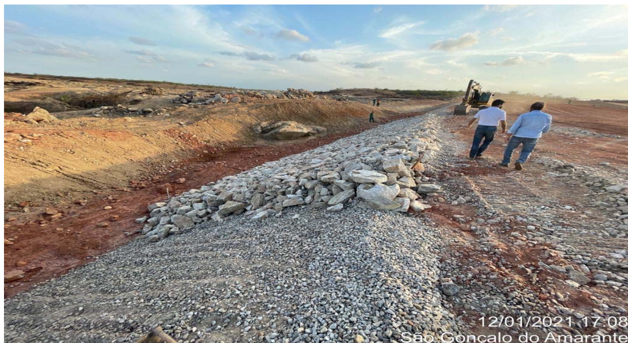
FOTO 35- Lançamento de rocha de proteção no rip-rap
