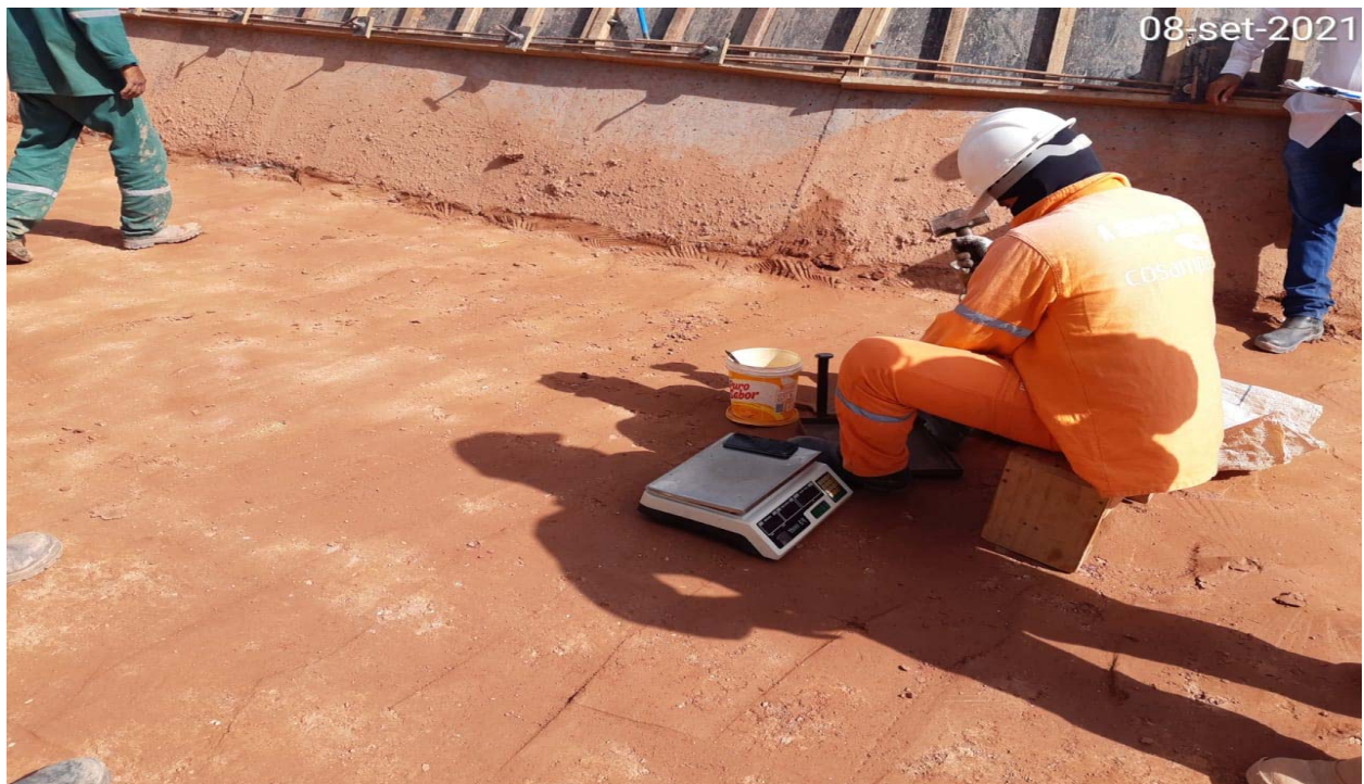
FOTO 144 – Ensaio de compactação – in situ (aterro do muro lateral direito)
