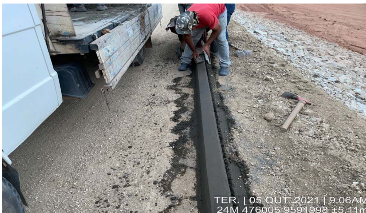
FOTO 152- Execução de meio fio da barragem Melancia
