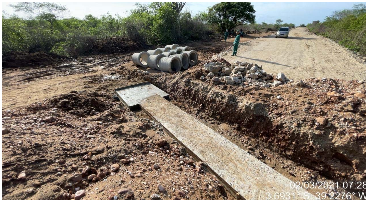
FOTO 61 – Execução de Bueiro 01 – estrada de acesso ao vertedouro
