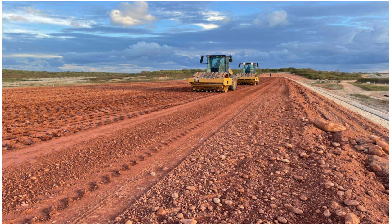
FOTO 115 - Compactação do material - maciço
