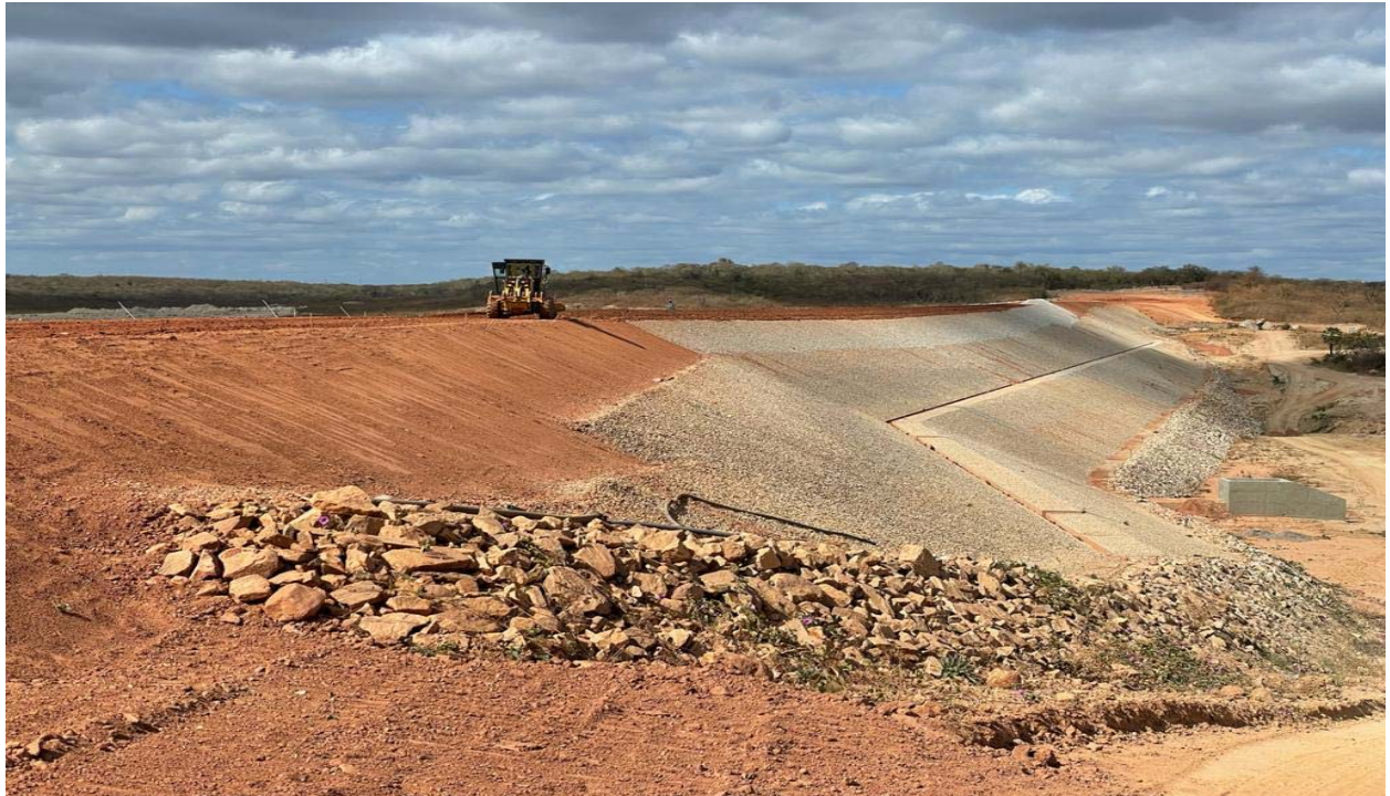
FOTO 135 - Tratamento do material e vista panorâmica da barragem Melancia
