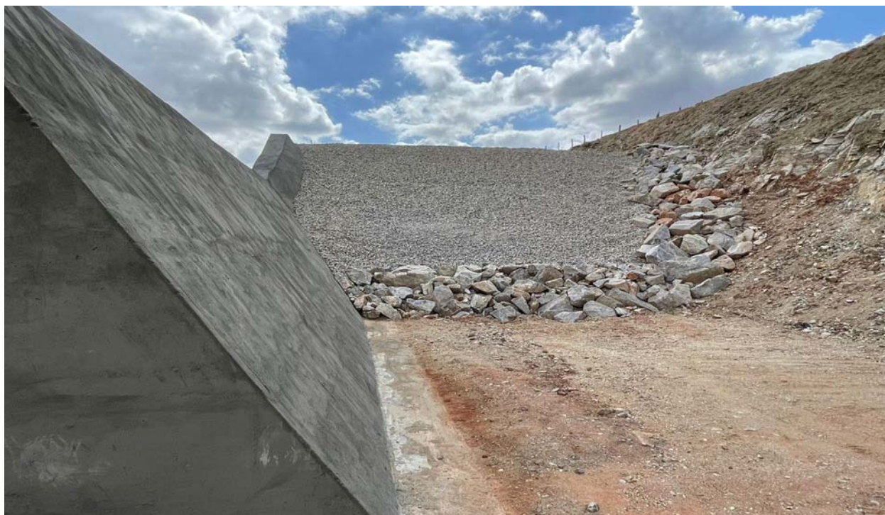
FOTO 174 - Aterro do muro lateral esquerdo.
